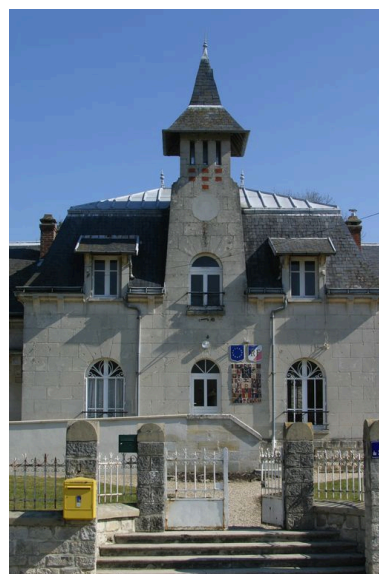
Vue du corps central. Phot. Irwin Leullier IVR22_20030202092NUCA
