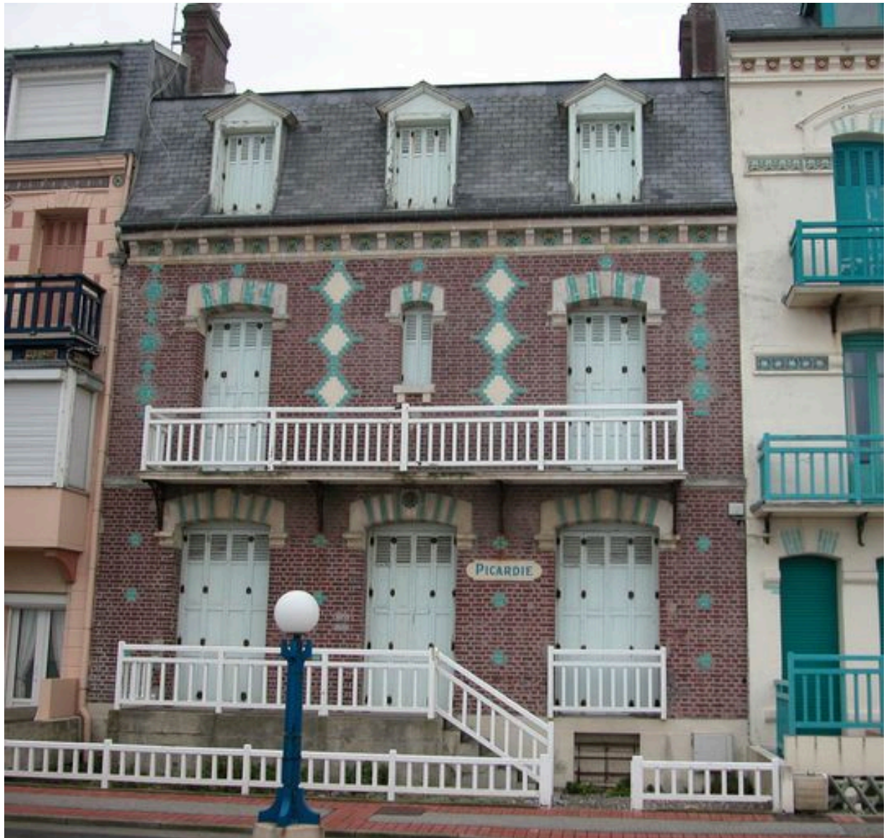
Vue d'ensemble depuis l'esplanade.
