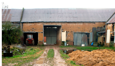
Vue générale des dépendances depuis la cour. Phot. Thierry Lefébure IVR22_20038001126NUCA
