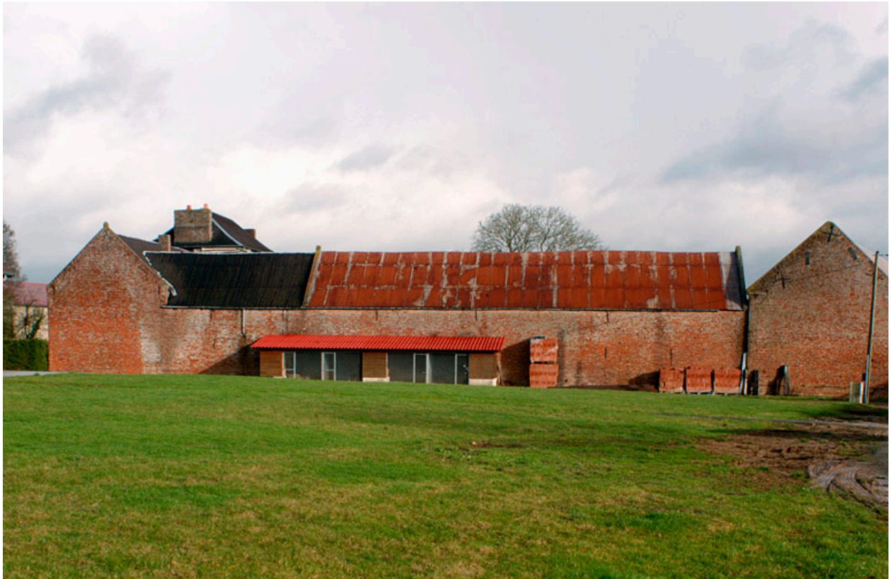
Vue générale des dépendances, depuis la rue.
