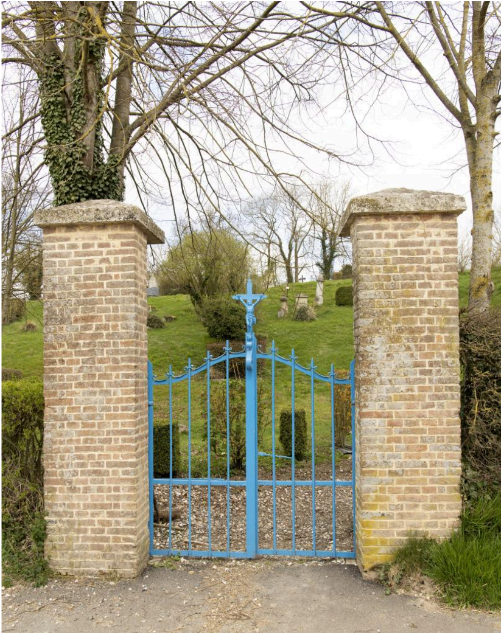
Vue générale de l'entrée sud du cimetière de Catheux, rue de Lavacquerie.
