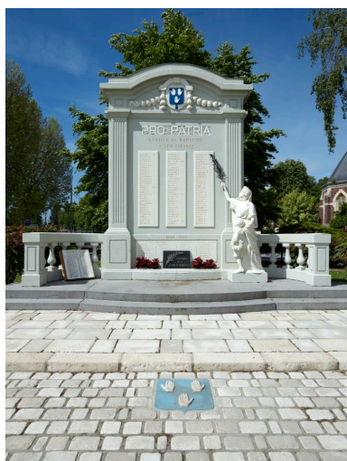
Vue générale de face. Phot. Delphine Volto-Jourdan IVR32_20216200569NUCA
