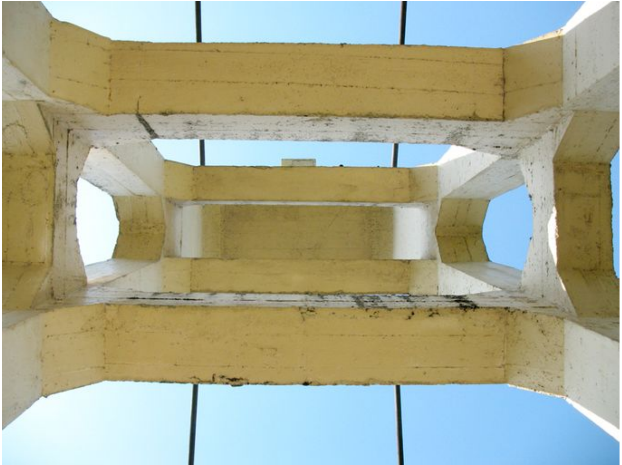
Détail de la structure de l'un des piliers.
