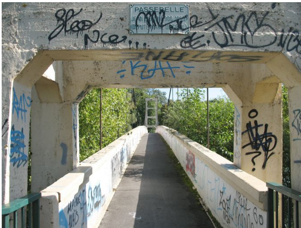
Vue générale de la largeur de la passerelle.
