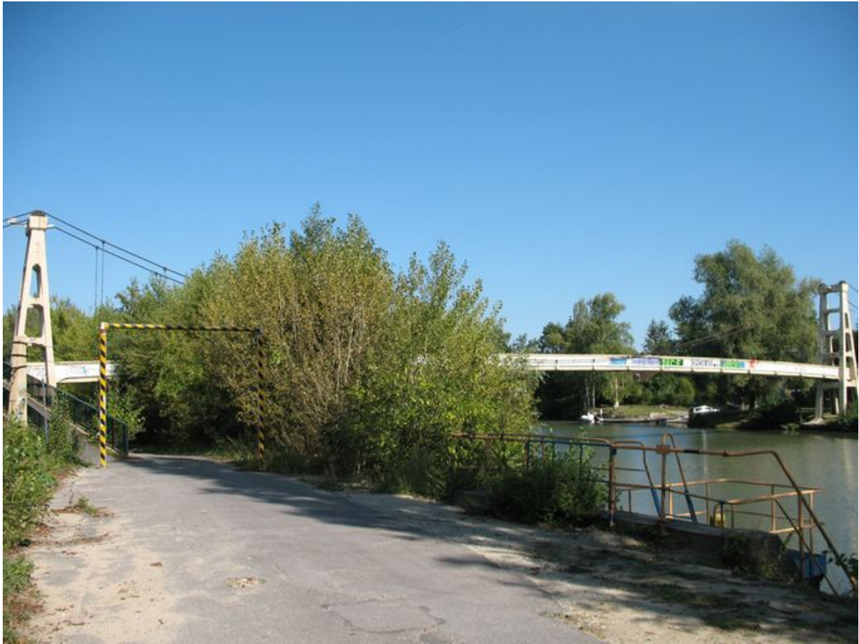
Vue générale de la passerelle depuis la rive droite (Villers-Saint-Paul) de l'Oise.
