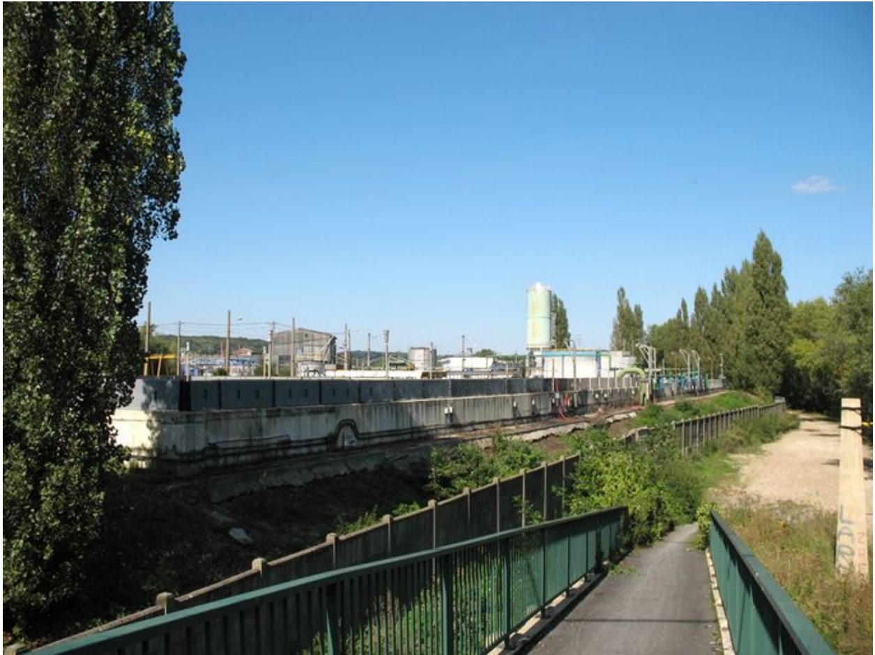
Débouché de la rampe d'accès du côté de l'usine chimique.
