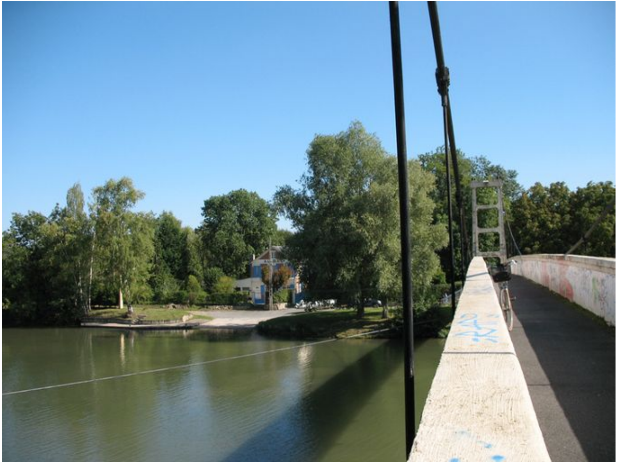
La passerelle et la maison du passeur sur la rive gauche de l'Oise (côté Verneuil-en-Halatte).
