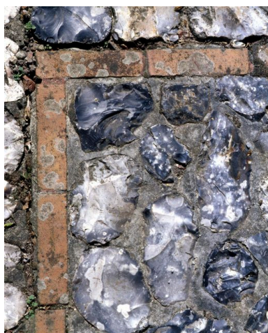
Détail de la mise en oeuvre de l'escalier menant au jardin (rognons de silex). Phot. Marie-Laure Monnehay-Vulliet IVR22_20048000321XA
