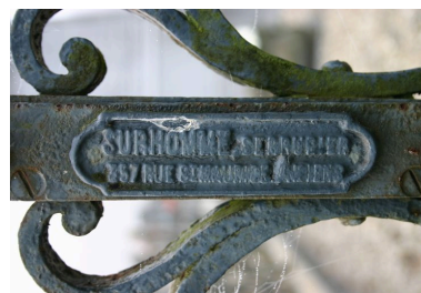
Portillon de clôture : signature du serrurier Surhomme. Phot. Caroline Vincent IVR22_20078001255NUCA
