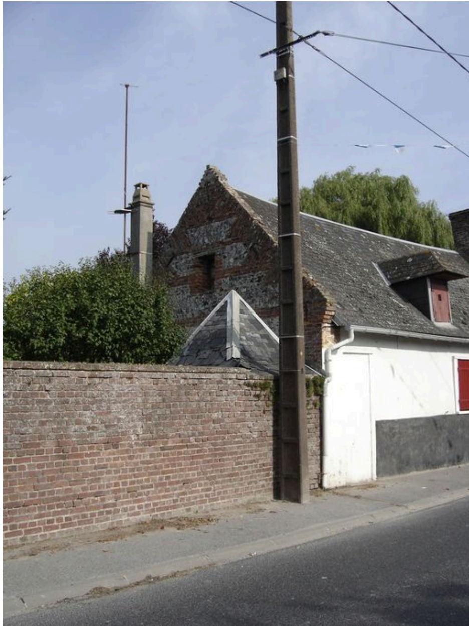
Détail d'un des deux pignons.
