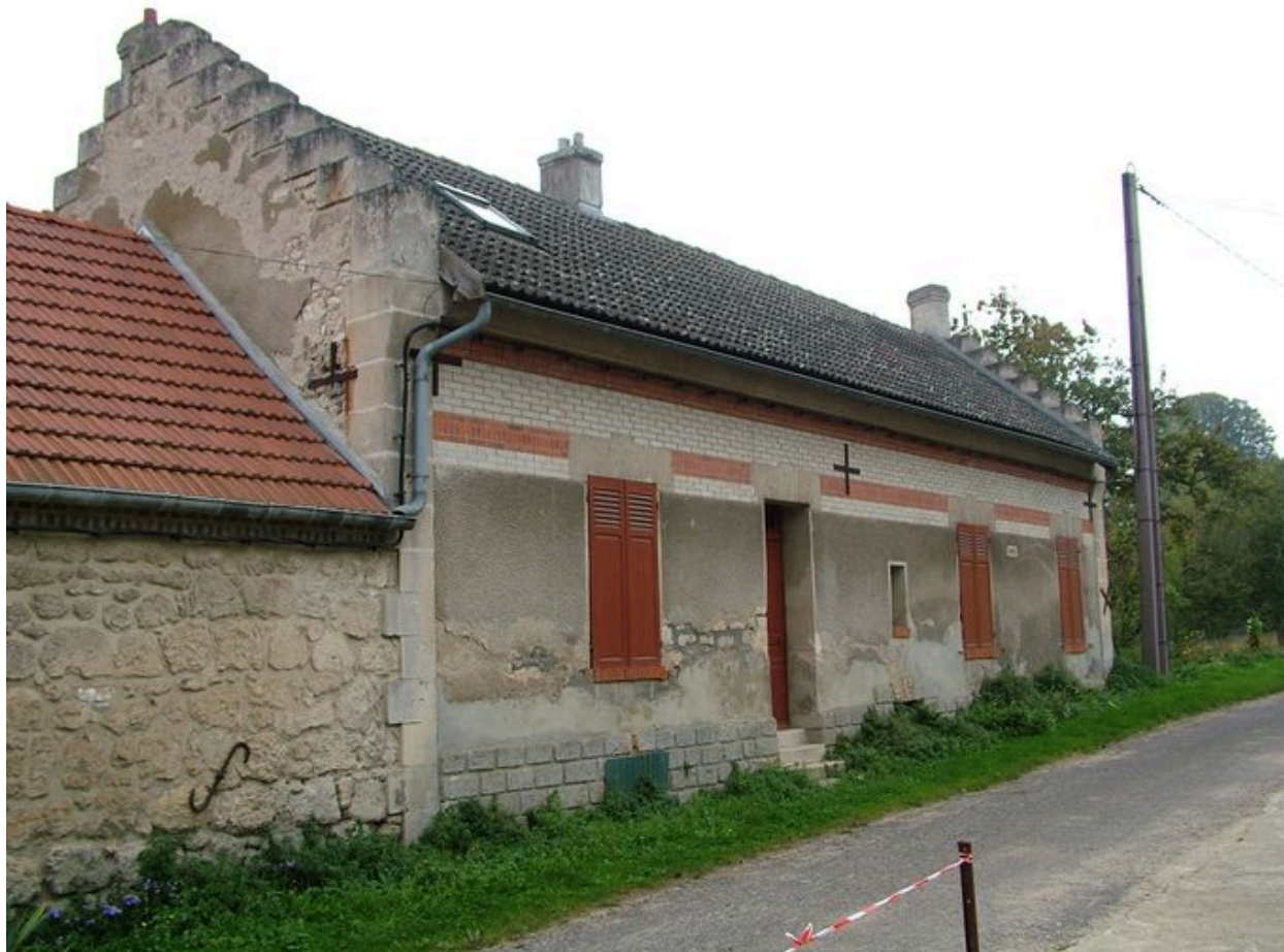
Vue postérieure du logis.
