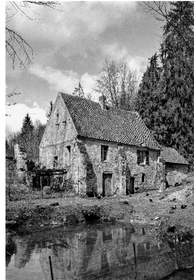
Vue du moulin de Fleury. Phot. Fabrice Charrondière IVR22_19860200286X
