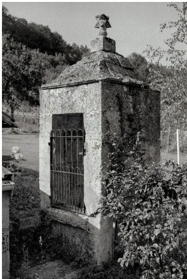
Vue d'un puits à Vivières (7 rue de la Vallée).
