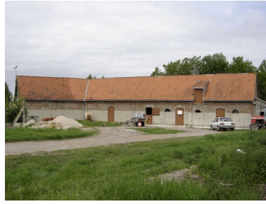
Vue générale des bâtiments agricoles. Phot. Inès Guérin IVR22_20058005762NUCA
