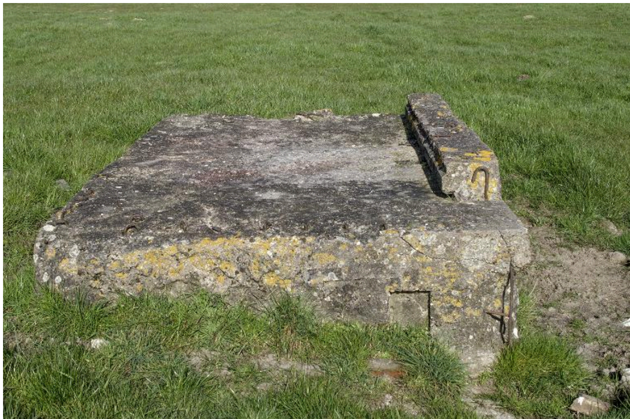
Vue latérale de l'abri, vers le nord-est
