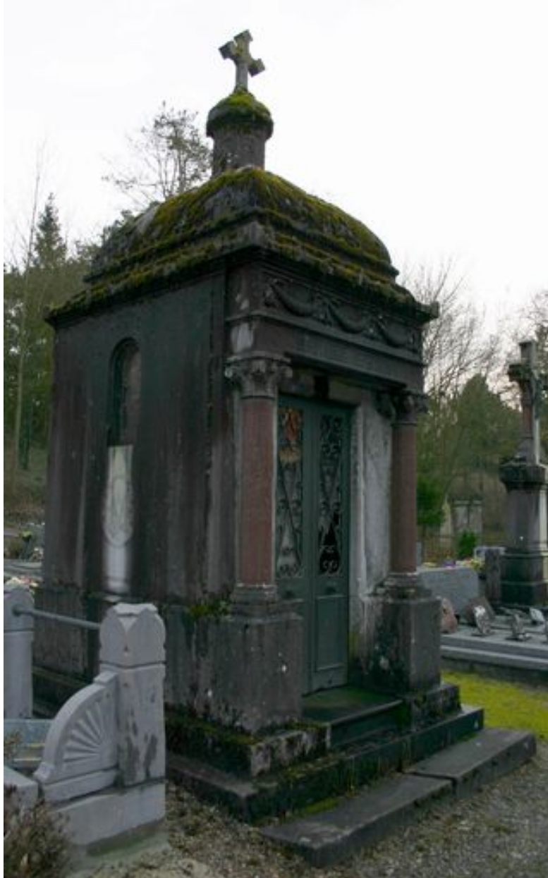
Vue générale du tombeau-chapelle, depuis le côté.
