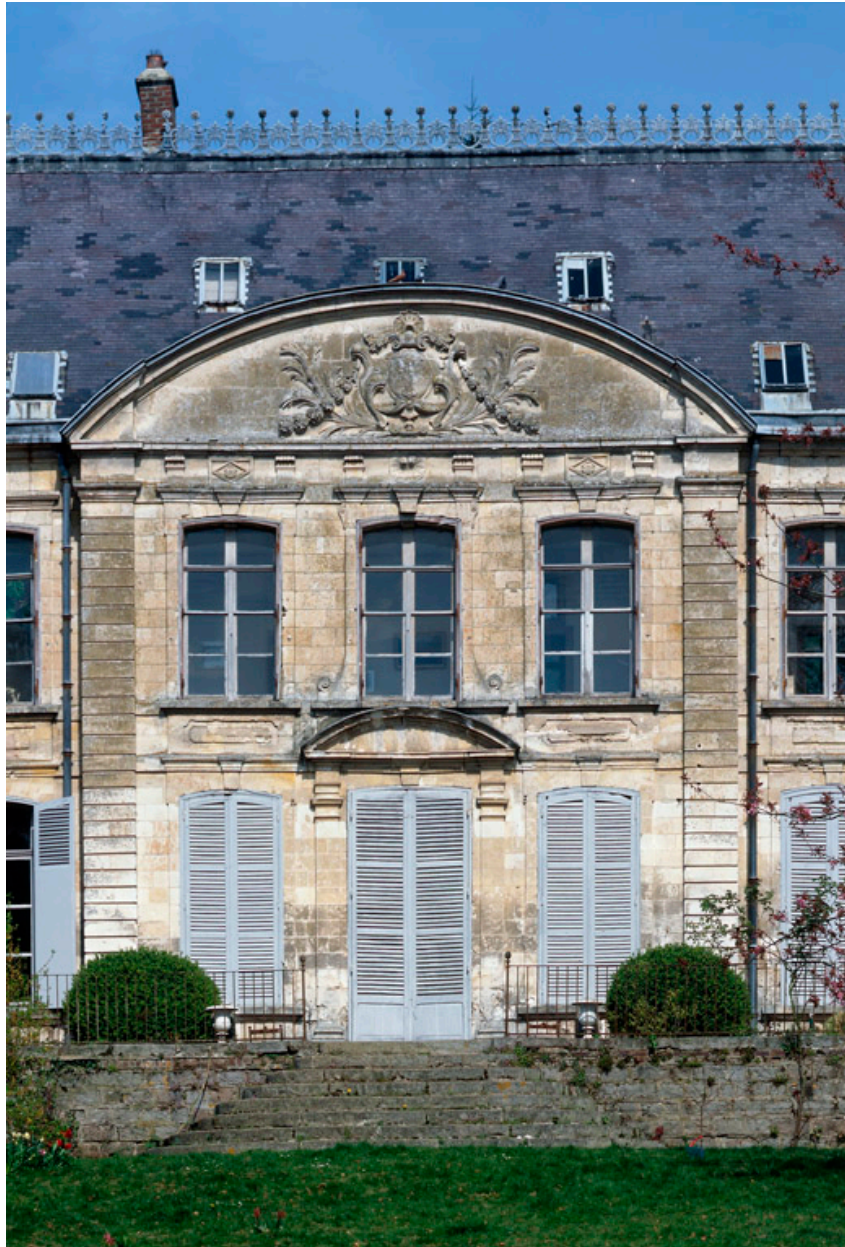
Façade antérieure, partie centrale.
