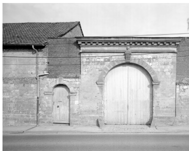
Ferme du château : portail d'entrée.
