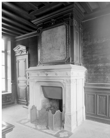
Cheminée de la salle de billard.
