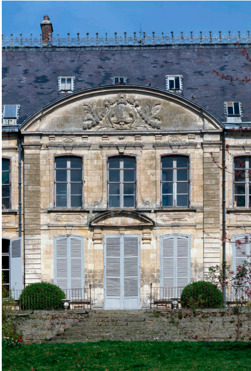
Façade antérieure, partie centrale.
