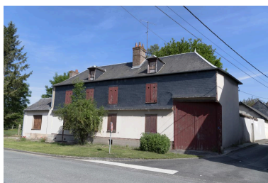
Logis sur rue avec entrée charretière, n°2 rue Gaillard, vue de la façade depuis le sud. Phot. Marc Kérignard IVR32_20216000567NUCA
