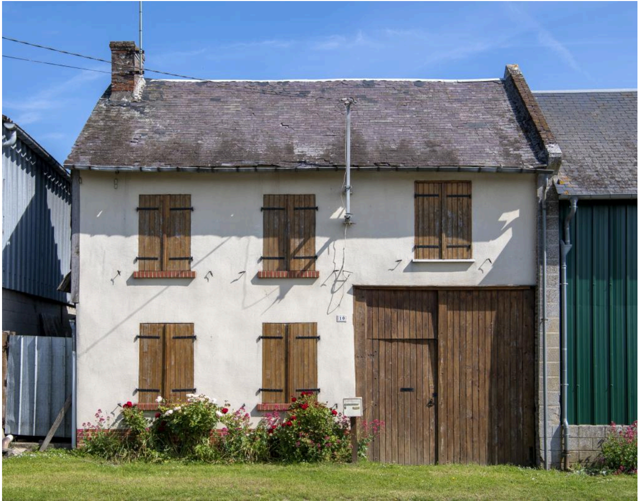
Logis sur rue avec entrée charretière, n°10 rue de la Ville, vue de la façade depuis le sud.
