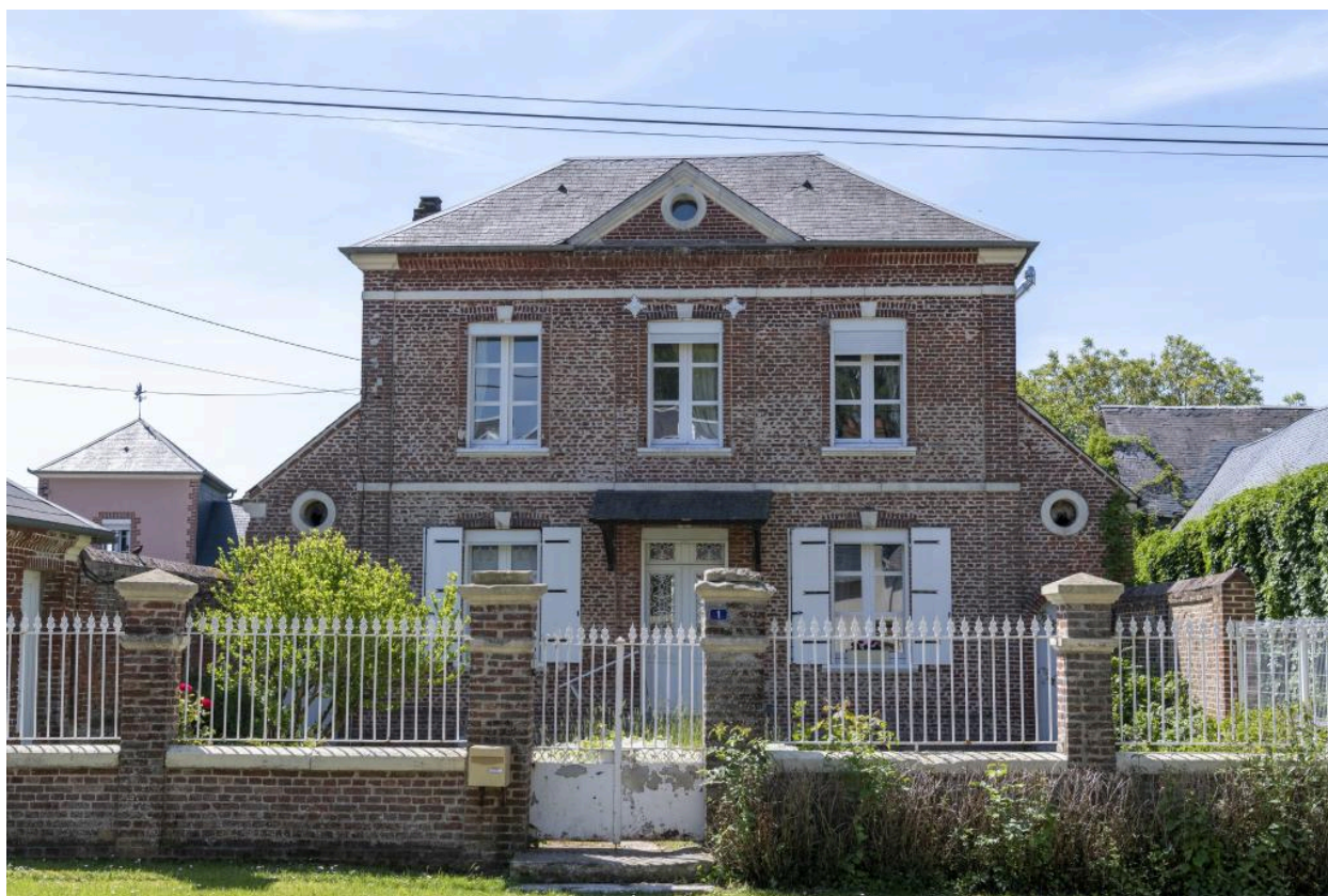
Ancien presbytère, n°1 rue Gaillard, vue de la façade depuis le nord.
