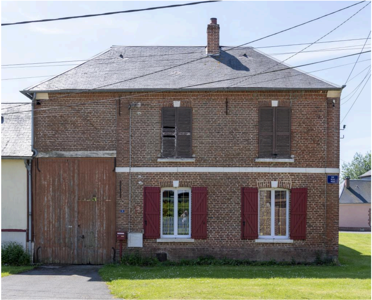
Logis sur rue avec entrée charretière, n°11 rue de la Ville, vue depuis le nord.
