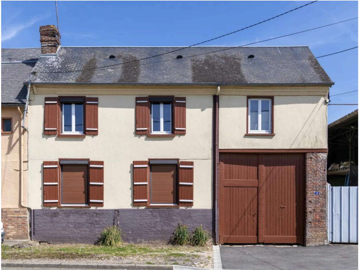
Logis sur rue avec entrée charretière, n°12 rue de la Ville, vue de la façade depuis le sud.
