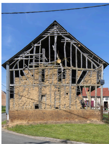
Grange, n°4 rue de la Ville, vue du pignon depuis l'ouest. Phot. Marc Kérignard IVR32_20216000582NUCA
