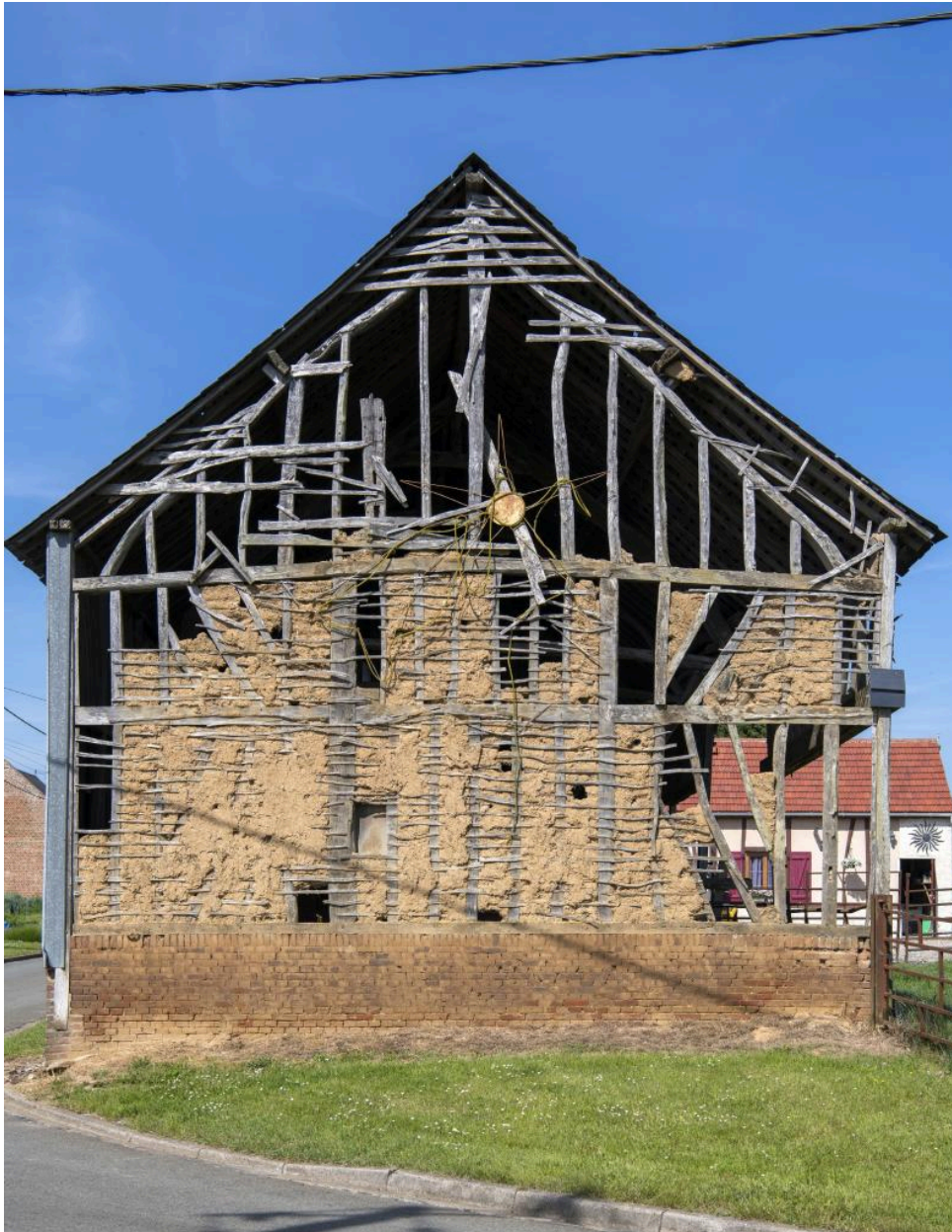
Grange, n°4 rue de la Ville, vue du pignon depuis l'ouest.
