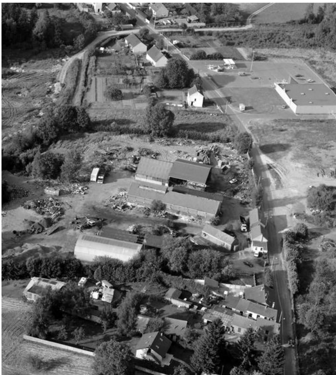
Vue aérienne du site industriel en 1994.
