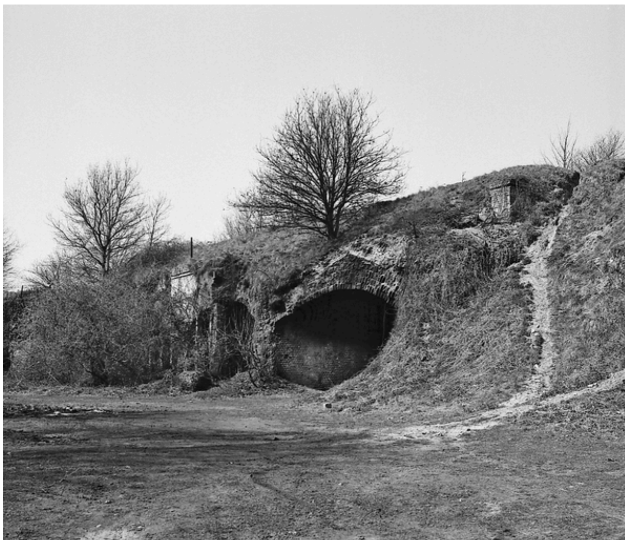
Vestiges du magasin à poudre nord.
