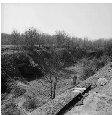
Vue générale, vers l'ouest. Phot. Philippe Dapvril IVR31_20045900192X
