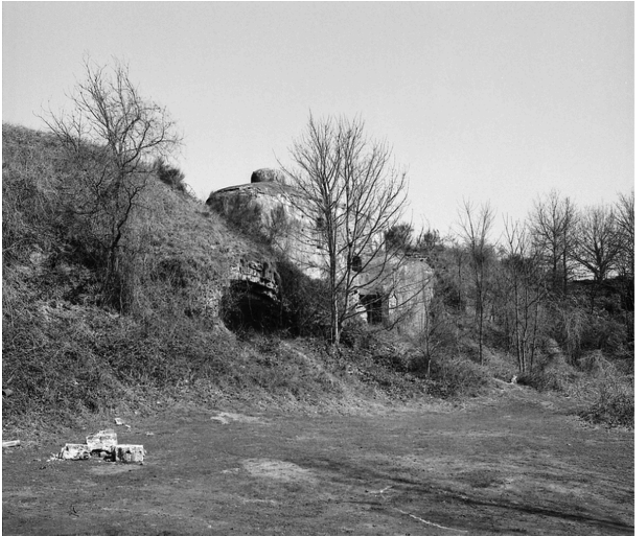
Vue générale de l'aile nord.
