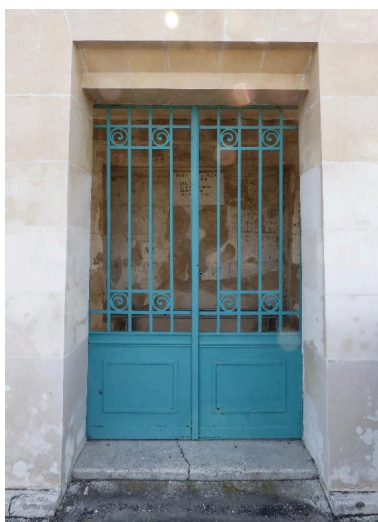
L'accès depuis le cimetière. Phot. Isabelle Barbedor IVR32_20170205274NUCA
