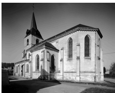
Élévation sud-est. Phot. Jean-Michel Perrin IVR22_19846001327V
