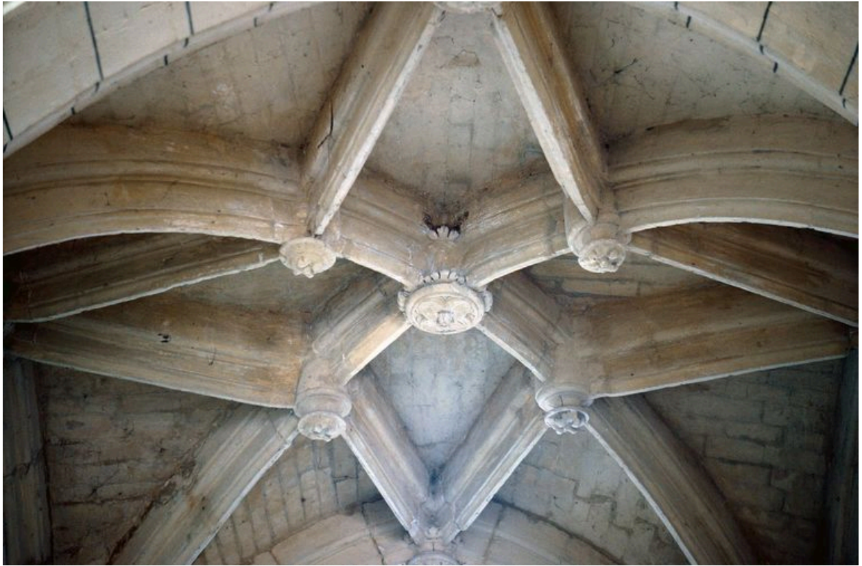
Détail des voûtes du bas-côté nord.
