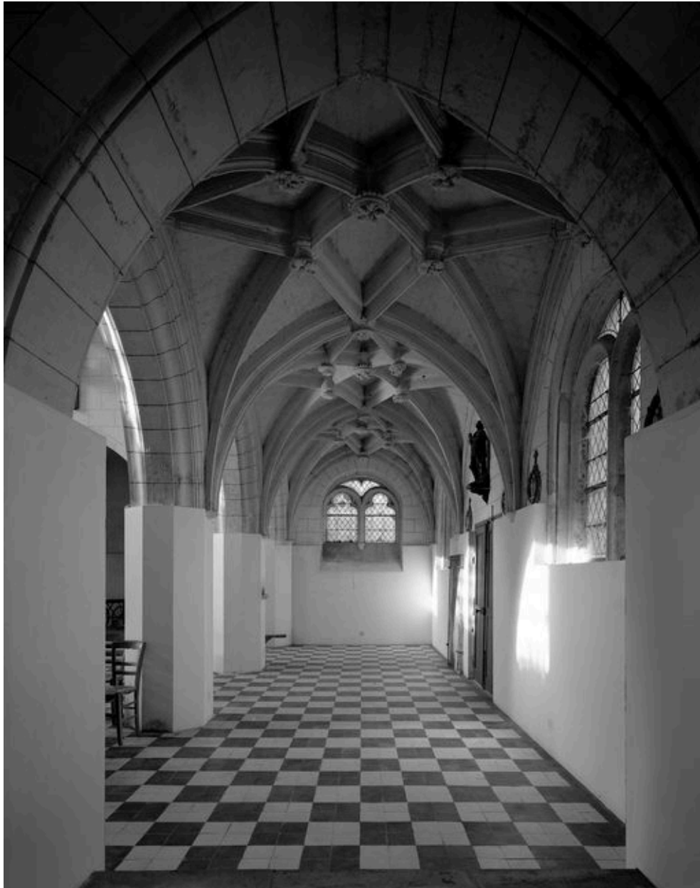
Bas-côté nord : vers l'ouest.
