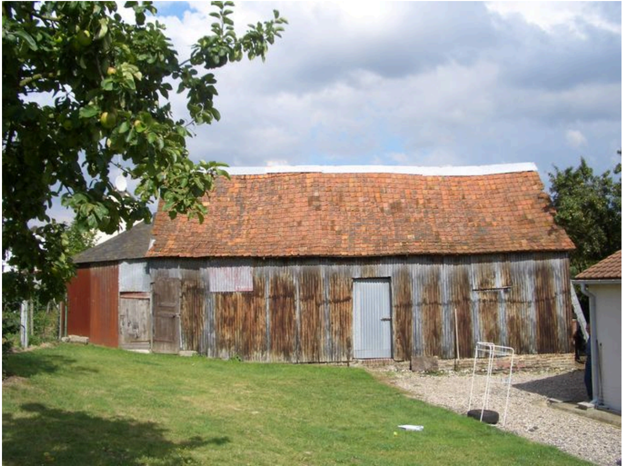
Vue de la grange.
