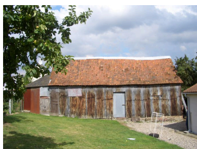
Vue de la grange. Phot. Inès Guérin IVR22_20068005142NUCA
