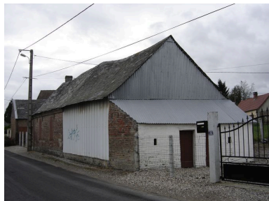
Vue du logis sur rue flanquée des étables. Phot. Inès Guérin IVR22_20068005139NUCA
