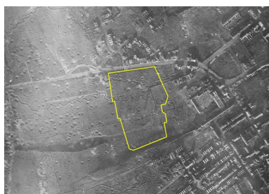
Vue aérienne du site d'implantation de la cité en novembre 1918 (AD Aisne). Phot. Pillet Frédéric
