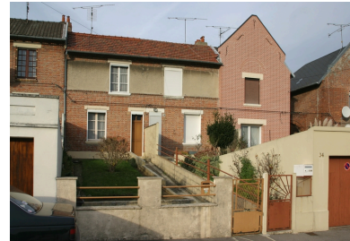
Deux logements, allée des Cerisiers. Phot. Frédéric Pillet IVR22_20070205041NUCA
