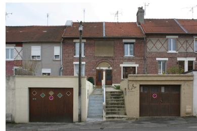
Façades rue du docteur Cordier. Phot. Frédéric Pillet IVR22_20070205044NUCA
