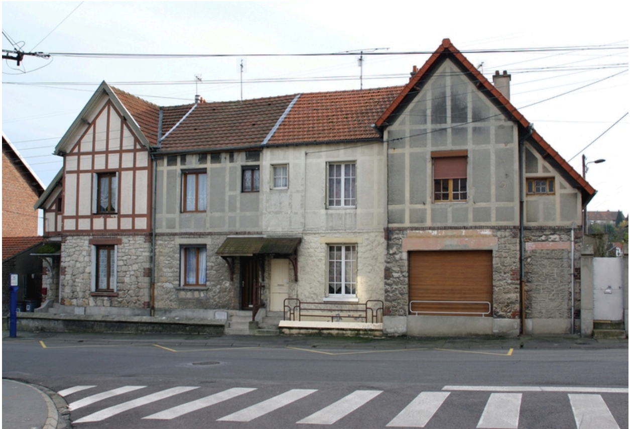
Groupe de 4 logements, rue du Docteur Cordier.
