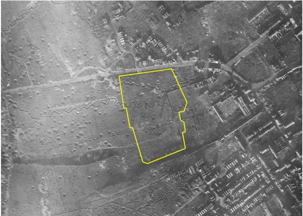
Vue aérienne du site d'implantation de la cité en novembre 1918 (AD Aisne).
