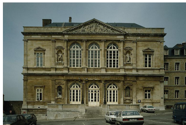
Vue générale de la façade. Phot. Jean-Michel Périn IVR31_19876201441XA
