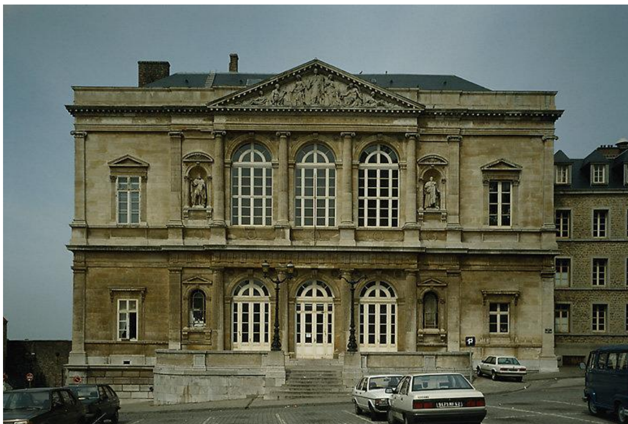
Vue générale de la façade.
