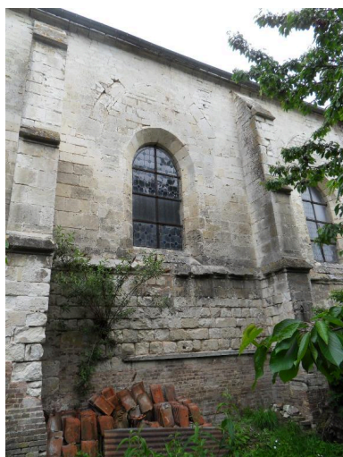
Baie du mur sud (deuxième travée). Phot. Isabelle Barbedor IVR22_20108010034NUCA
