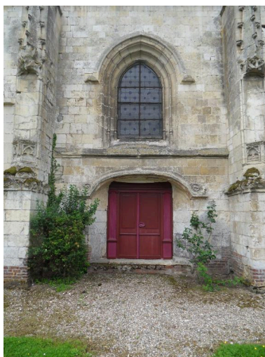
Travée du portail nord Phot. Isabelle Barbedor IVR22_20108010025NUCA
