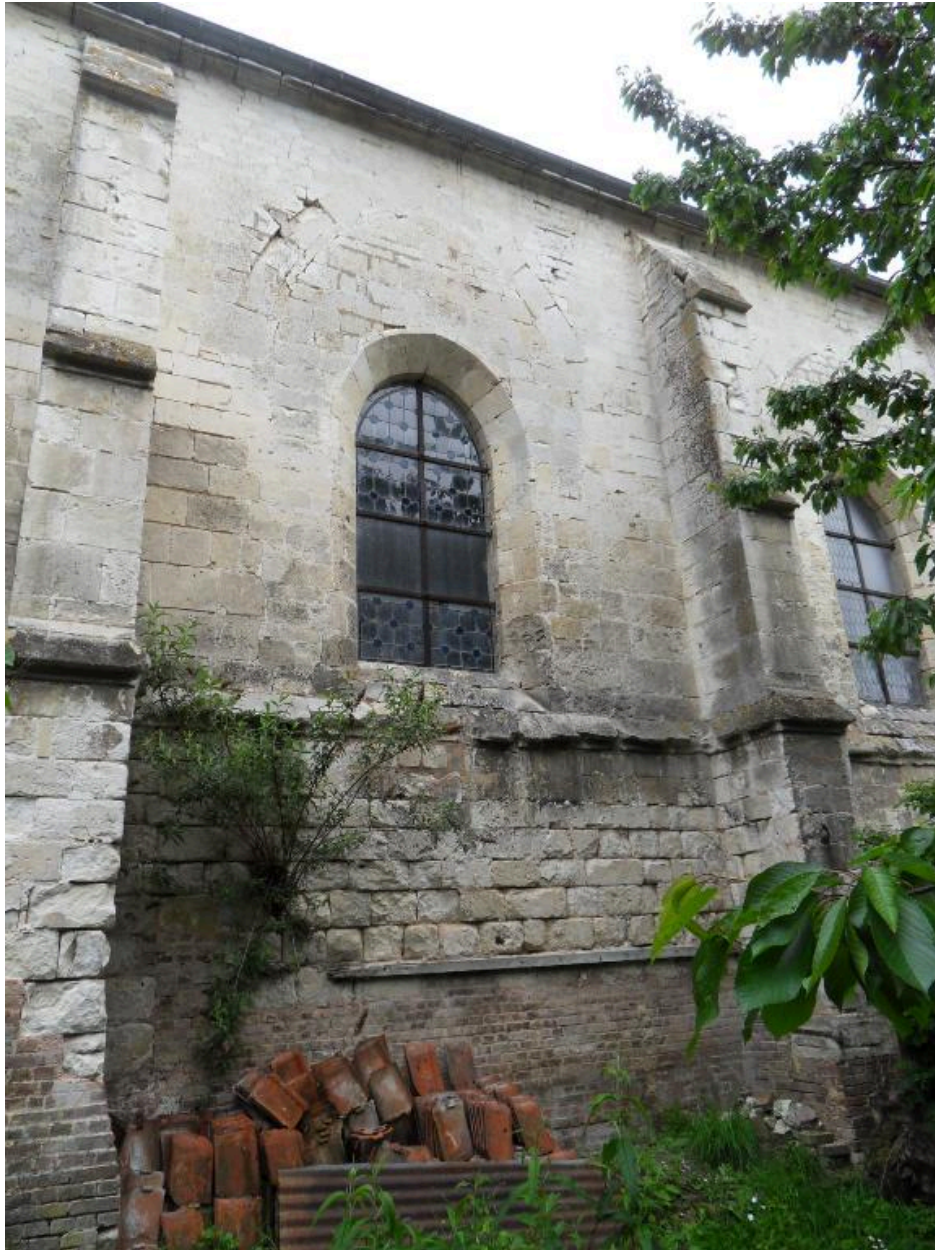
Baie du mur sud (deuxième travée).
