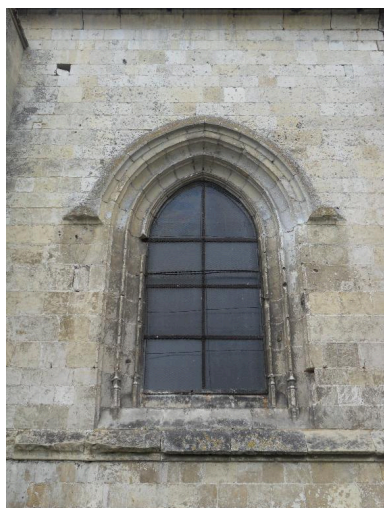
Baie du mur nord. Phot. Isabelle Barbedor IVR22_20108010032NUCA
