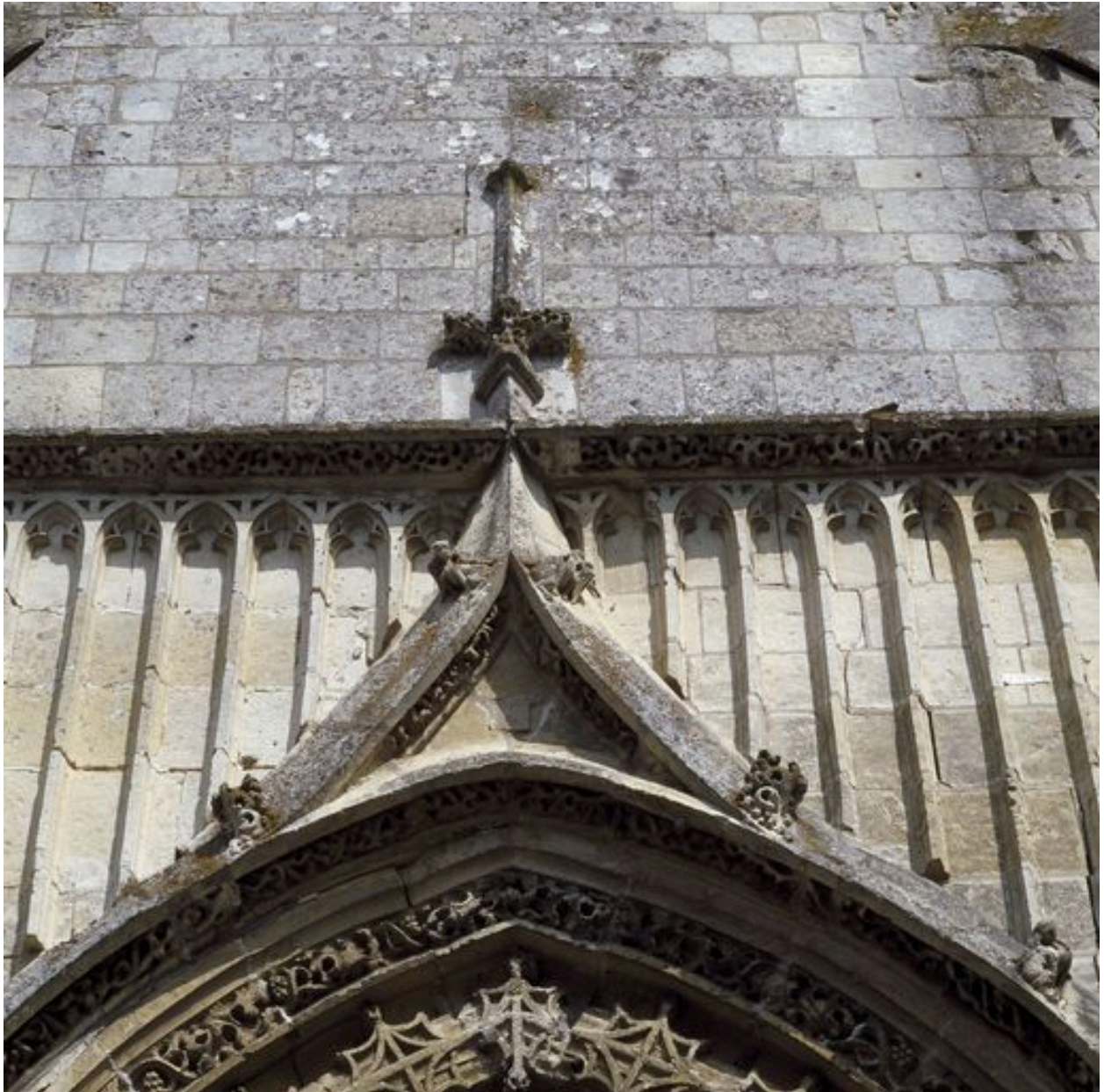
Détail de la façade occidentale.
