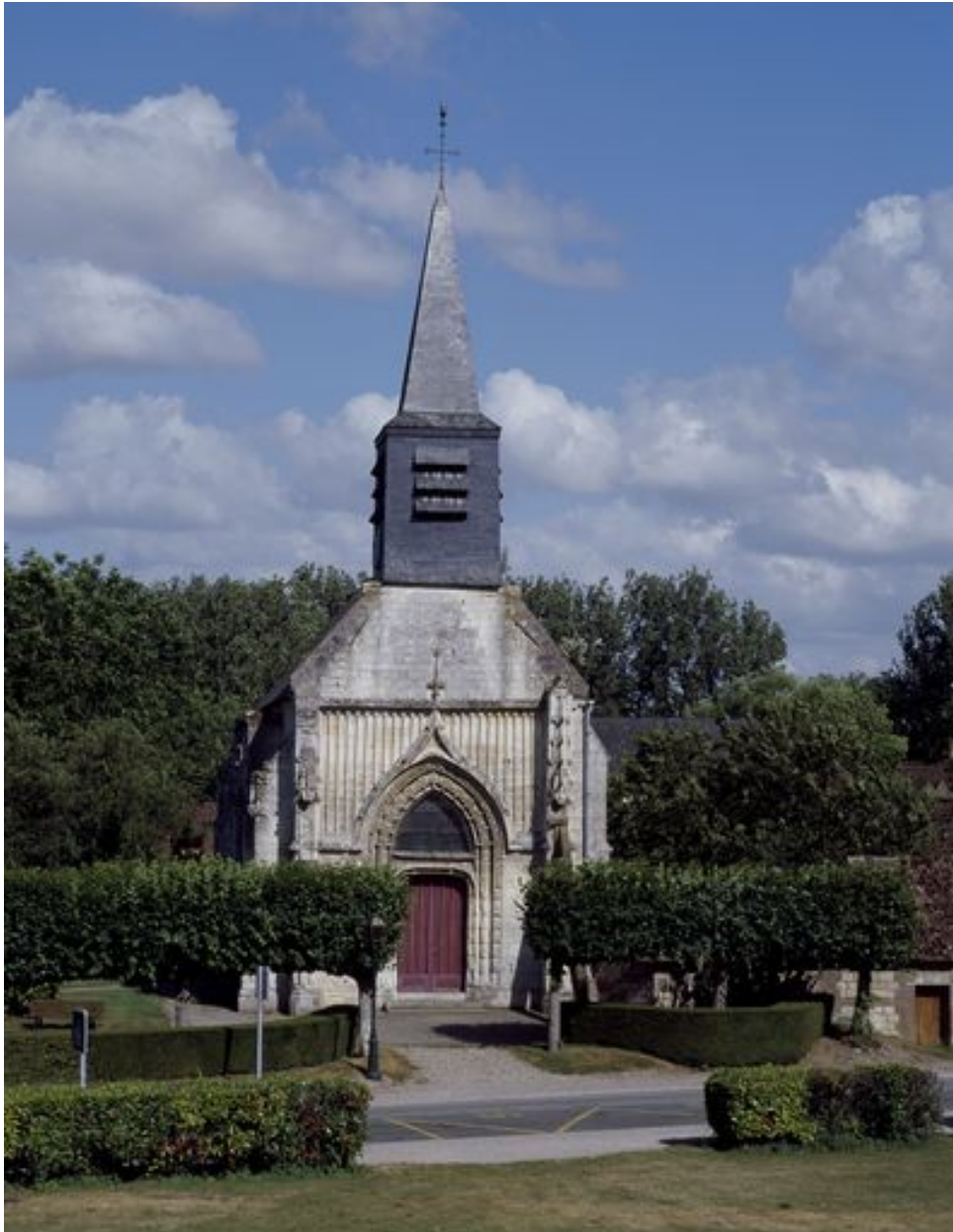
Vue de la façade occidentale.
