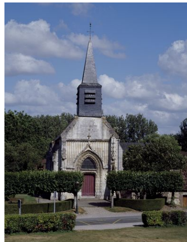
Vue de la façade occidentale. Phot. Marie-Laure Monnehay-Vulliet IVR22_20108000227XA
