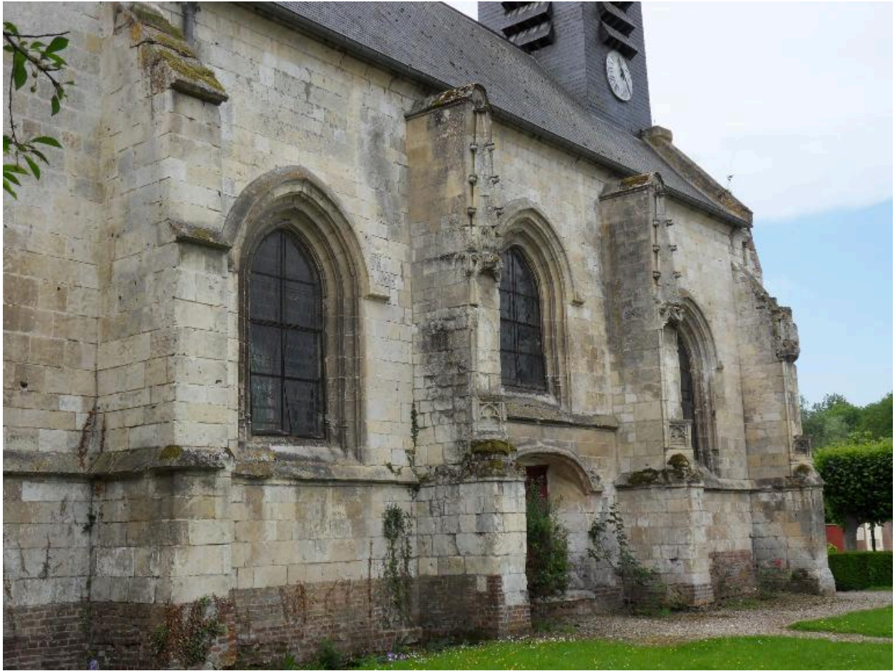
Travées ouest du mur nord de la nef.
