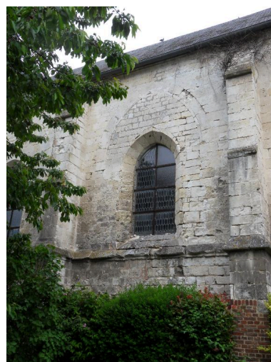
Baie du mur sud. Phot. Isabelle Barbedor IVR22_20108010033NUCA
