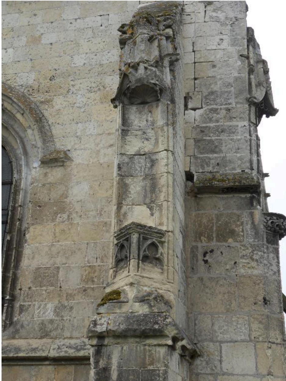
Détail sur le contrefort (angle nord-ouest)
