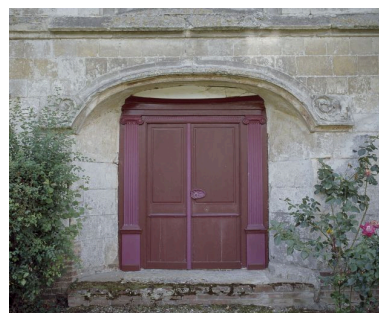
Portail nord. Phot. Marie-Laure Monnehay-Vulliet IVR22_20108000304XA
