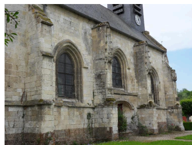
Travées ouest du mur nord de la nef. Phot. Isabelle Barbedor IVR22_20108010031NUCA
