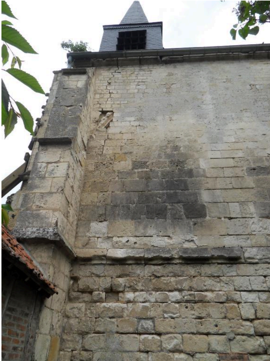
Trace de la baie du mur sud (première travée).
