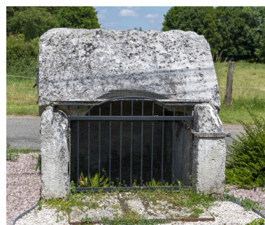
Puits en forme d'édicule architecturé, pierre calcaire, en face du n°14bis Grande Rue. Phot. Marc Kérignard IVR32_20216000636NUCA
