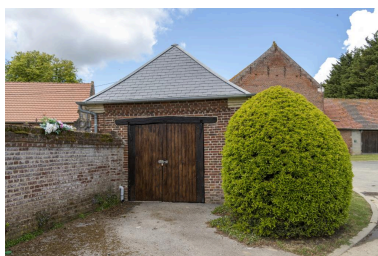
Bâtiment des pompes à incendie, vers 1901. Phot. Marc Kérignard IVR32_20216000412NUCA
