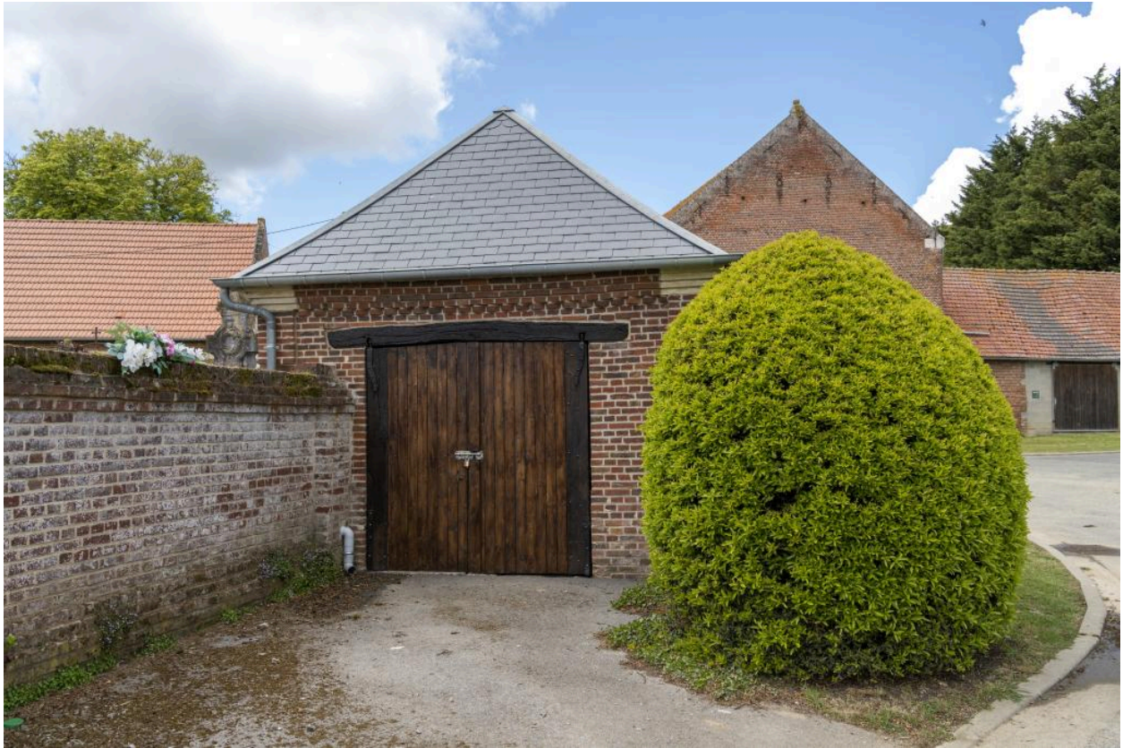
Bâtiment des pompes à incendie, vers 1901.
