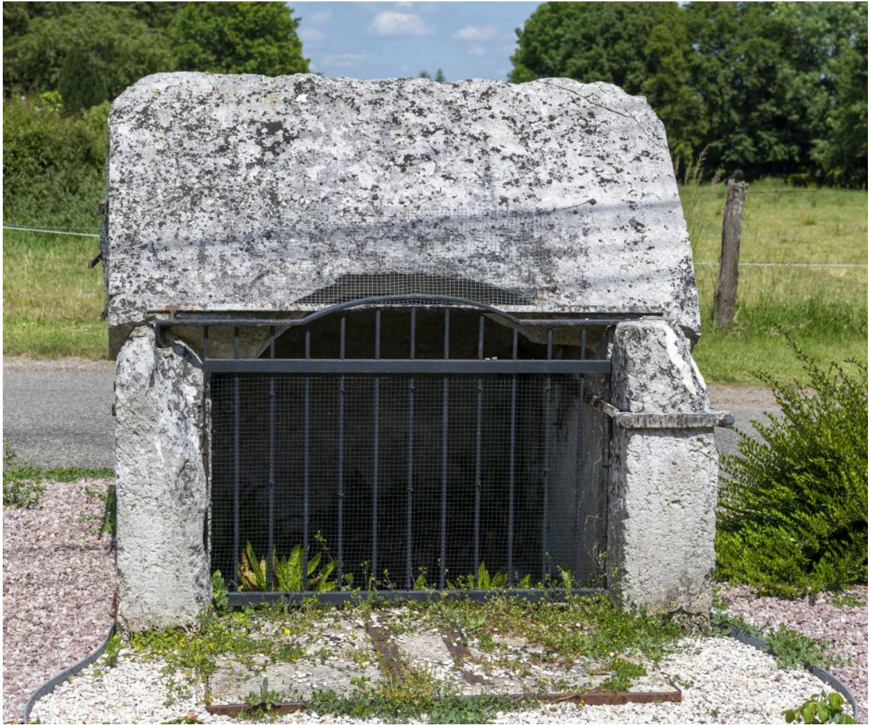
Puits en forme d'édicule architecturé, pierre calcaire, en face du n°14bis Grande Rue.
