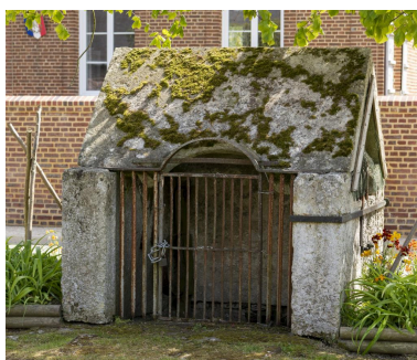
Puits en forme d'édicule architecturé, blocs de calcaire, en face de la mairie-école. Phot. Marc Kérignard IVR32_20216000424NUCA
