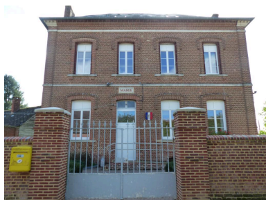
Façade sur rue de la mairie-école, n°34 Grande Rue, vue depuis le nord. Phot. Lucile Chamignon IVR22_20216005059NUCA
