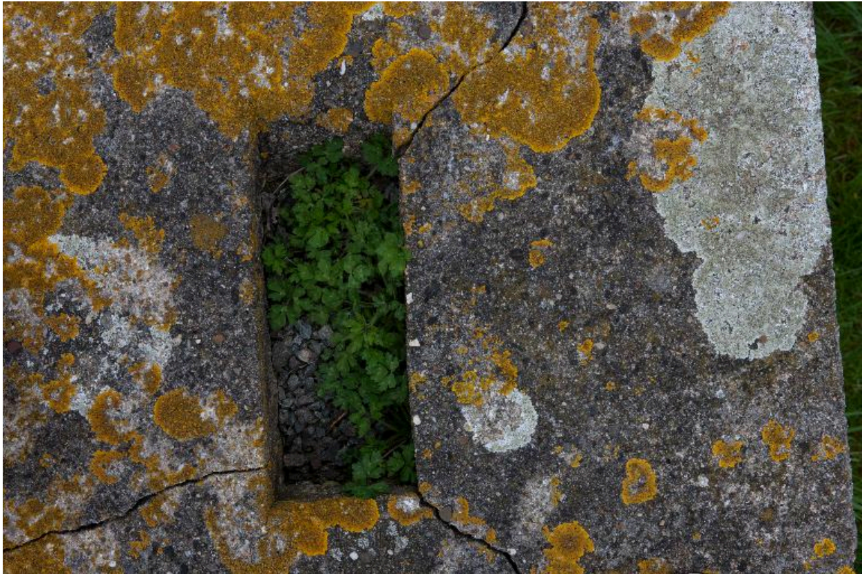
Plot. Vue de détail de la face supérieure.
