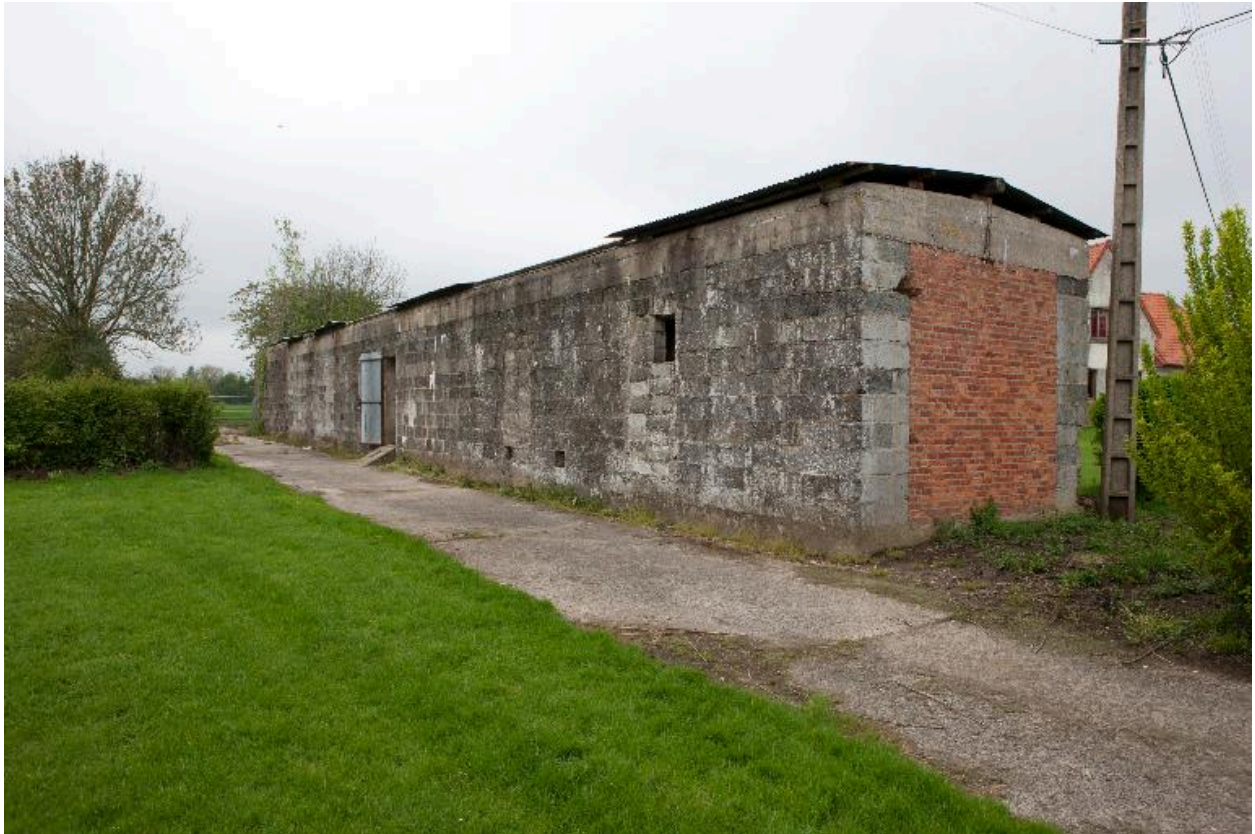
Bâtiment de stockage d'attente. Vue générale.
