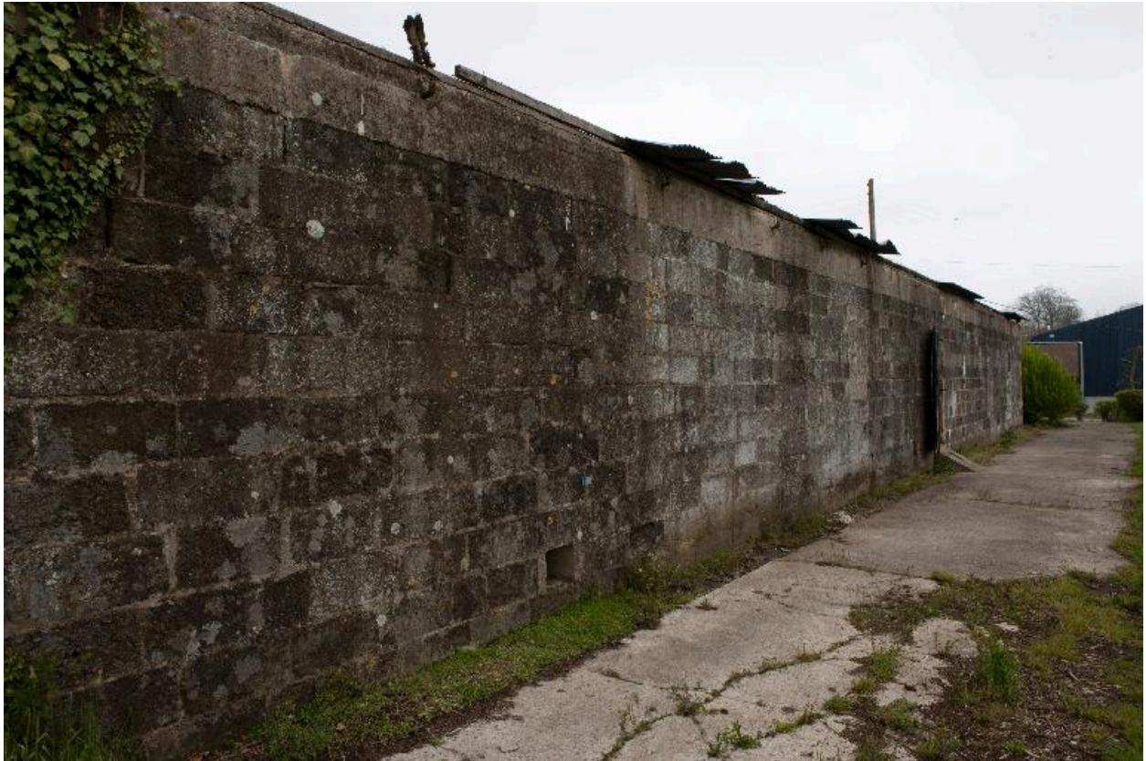
Bâtiment de stockage d'attente. Détail de l'élévation.
