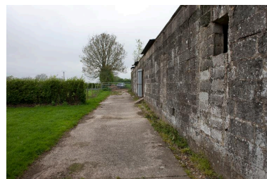
Bâtiment de stockage d'attente. Détail de l'élévation. Phot. Pierre Thibaut IVR31_20126201743NUCA
