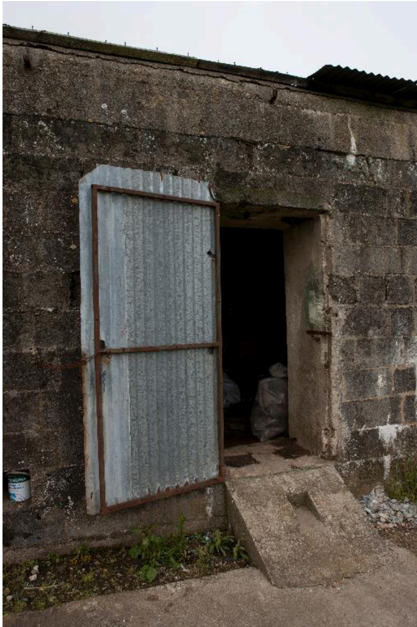
Bâtiment de stockage d'attente. Détail de la porte.
