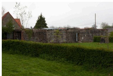
Bâtiment de stockage d'attente. Vue générale. Phot. Pierre Thibaut IVR31_20126201722NUCA
