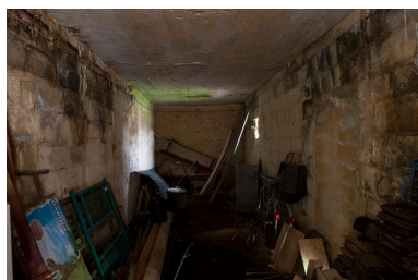
Bâtiment de stockage d'attente. Vue intérieure. Phot. Pierre Thibaut IVR31_20126201746NUCA
