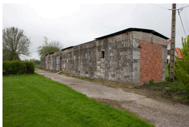
Bâtiment de stockage d'attente. Vue générale. Phot. Pierre Thibaut IVR31_20126201742NUCA
