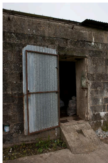
Bâtiment de stockage d'attente. Détail de la porte. Phot. Pierre Thibaut IVR31_20126201744NUCA
