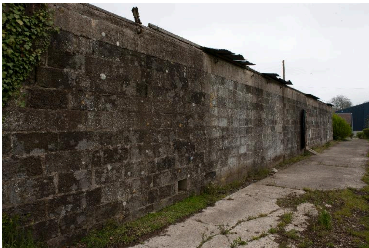
Bâtiment de stockage d'attente. Détail de l'élévation.
