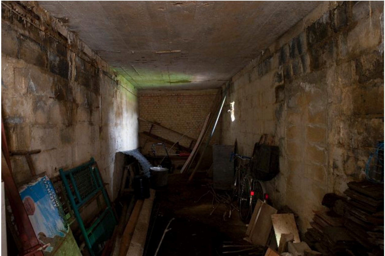
Bâtiment de stockage d'attente. Vue intérieure.
