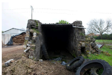
Vue de détail du premier abri de stockage en forme de ski. Phot. Pierre Thibaut IVR31_20126201751NUCA
