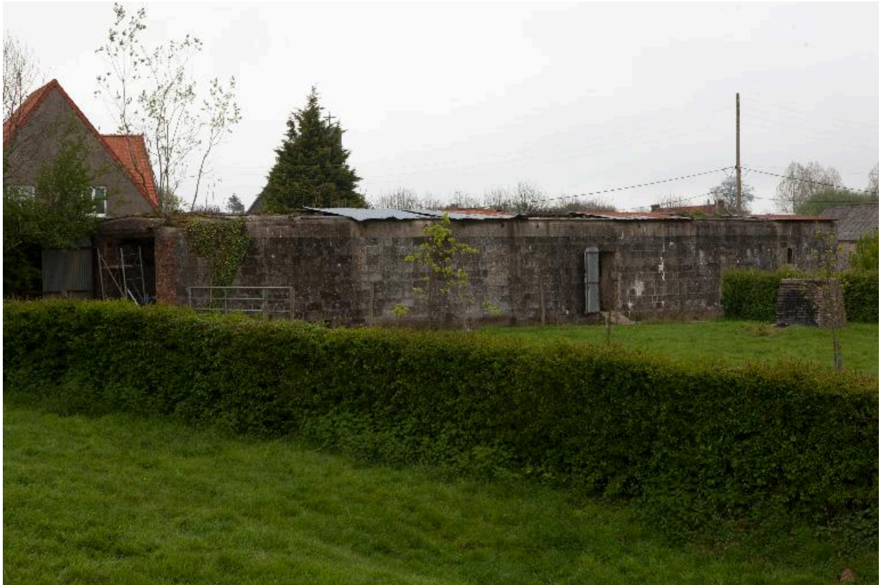
Bâtiment de stockage d'attente. Vue générale.
