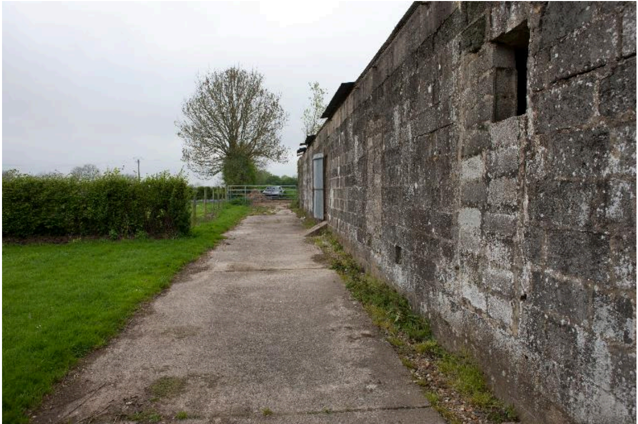
Bâtiment de stockage d'attente. Détail de l'élévation.
