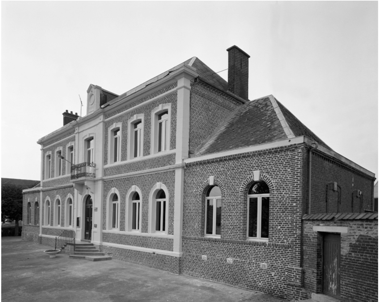
Vue d'ensemble de la façade.
