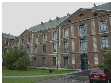
Façade sur cour du bâtiment ouest Phot. Bruno Decrock IVR31_20106208243NUCA
