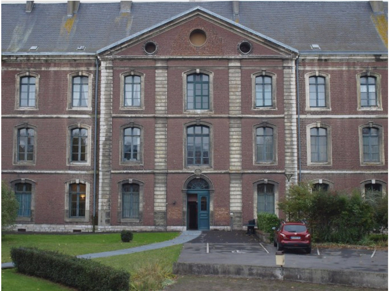
Pavillon central du bâtiment ouest
