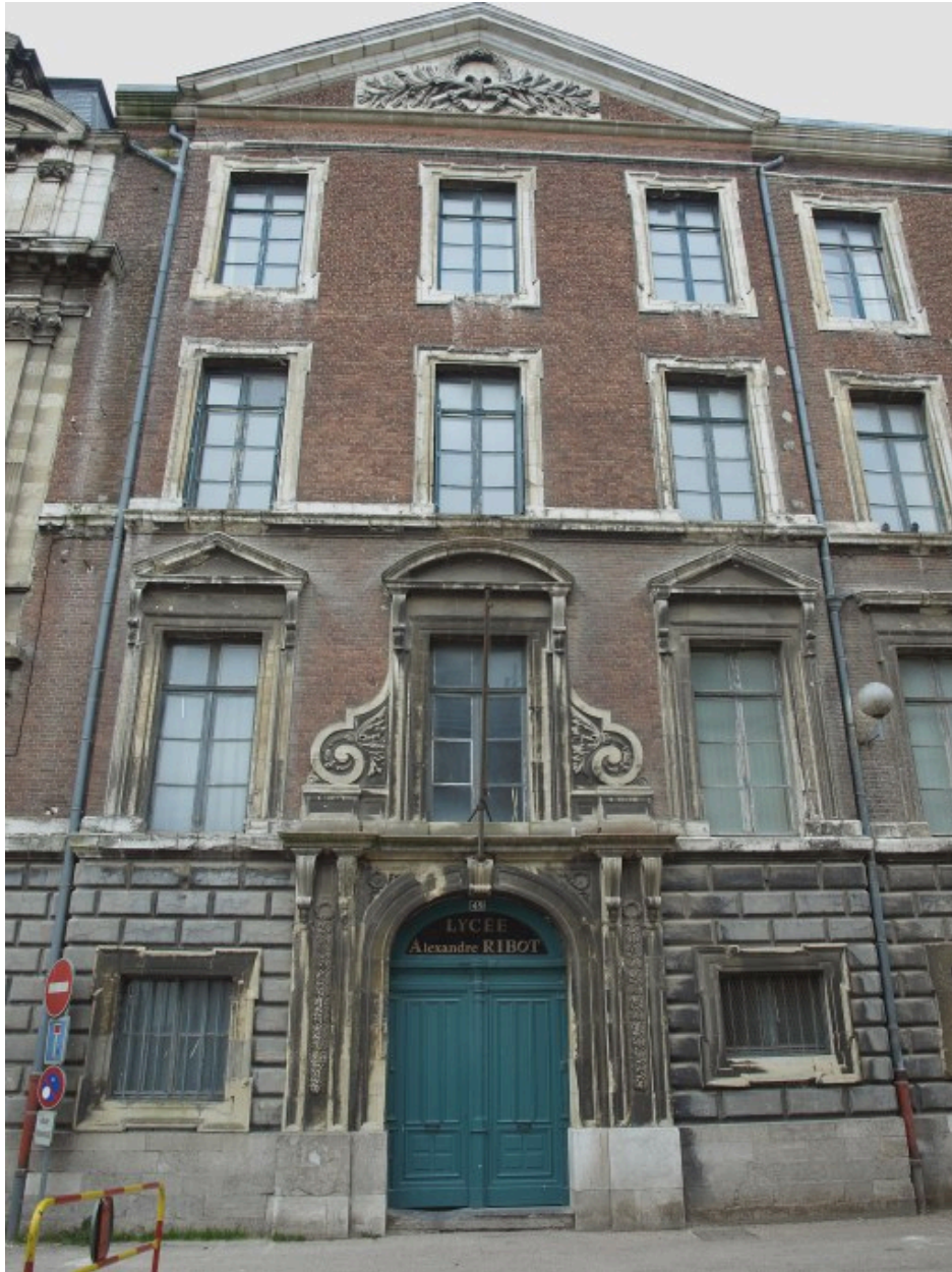
Façade rue Gambetta ; porte d'accès au bâtiment ouest
