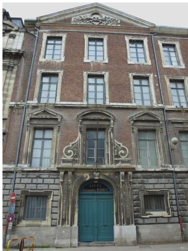
Façade rue Gambetta ; porte d'accès au bâtiment ouest Phot. Bruno Decrock IVR31_20106208249NUCA
