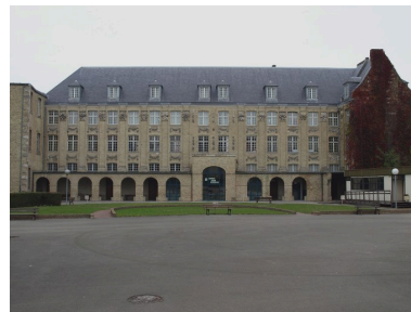
Façade sur cour du bâtiment de l'ancien collège des Jésuites anglais Phot. Bruno Decrock IVR31_20106208246NUCA
