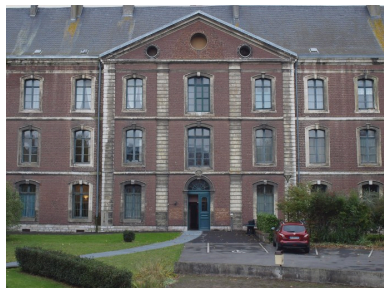
Pavillon central du bâtiment ouest Phot. Bruno Decrock IVR31_20106208244NUCA
