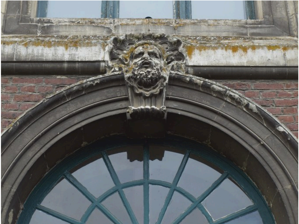
Mascaron au-dessus de l'entrée sur cour du bâtiment ouest
