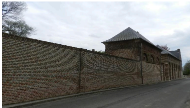
Les communs et le mur de clôture depuis la rue de Poireauville en direction de Vaudricourt. Phot. Romain Grimaud IVR22_20128005013NUC2A
