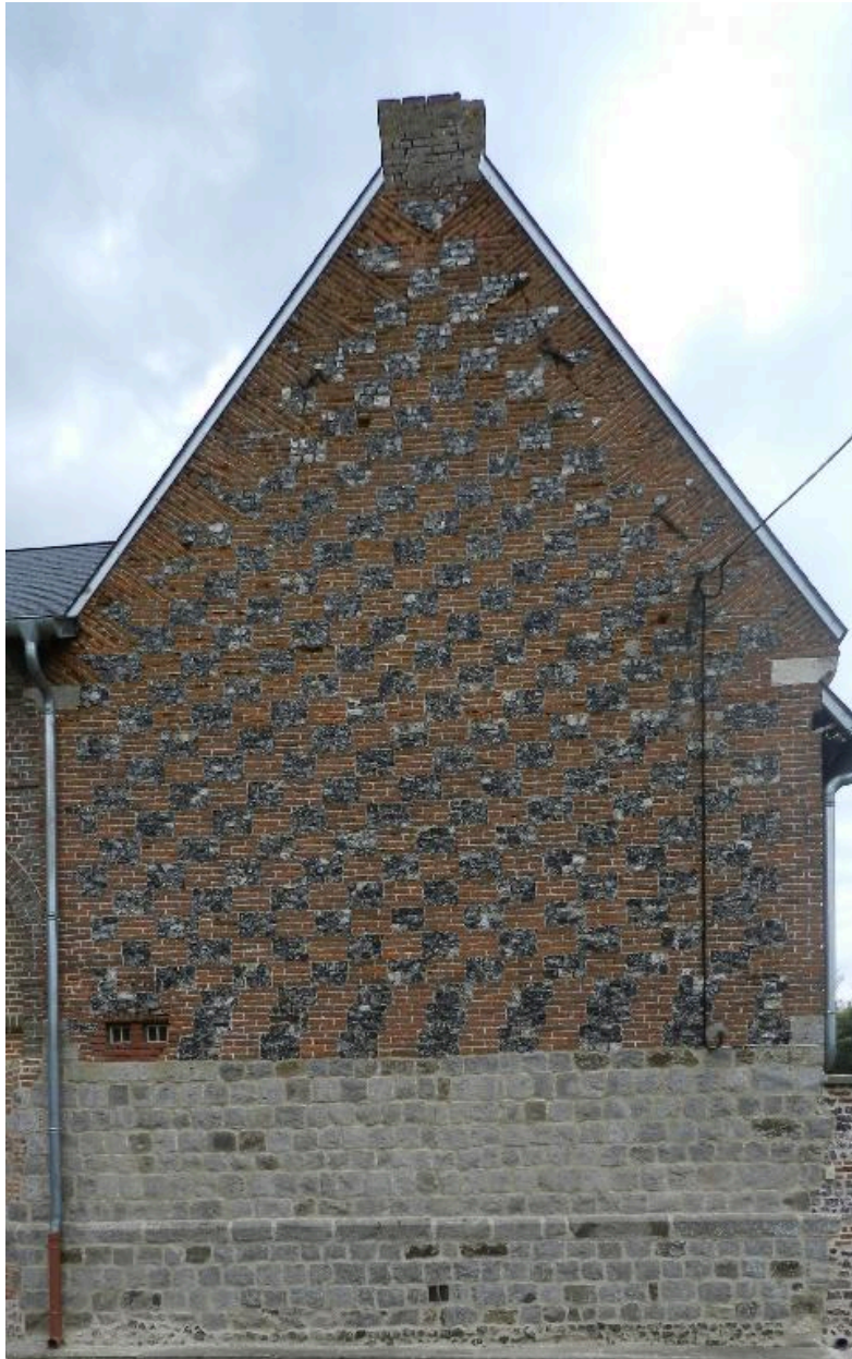
Le mur-pignon du manoir depuis la rue.
