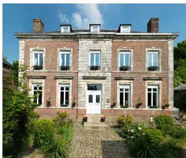
Façade sur cour. Phot. Thierry Lefébure IVR22_20138000195NUC2AQ
