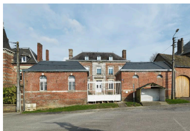
Vue d'ensemble depuis la place. Phot. Thierry Lefébure IVR22_2013800085NUC2A
