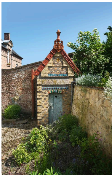
Latrine extérieure, vue de face
