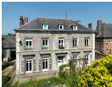
Façade postérieure, vue de face. Phot. Thierry Lefébure IVR22_20138000196NUC2A
