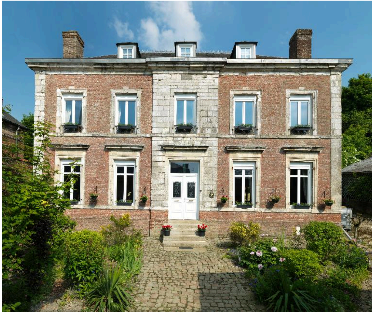
Façade sur cour.
