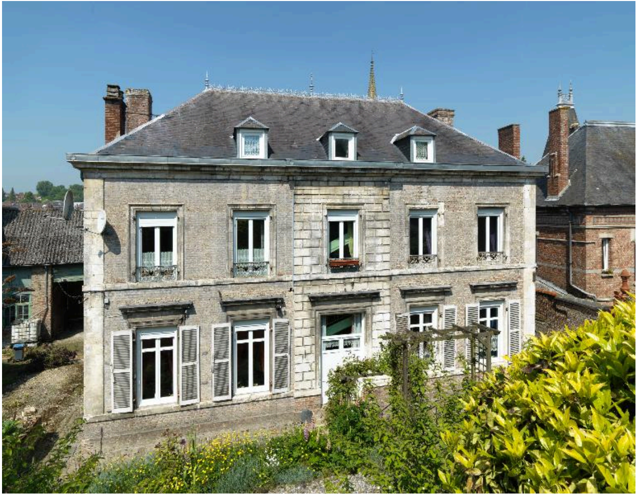
Façade postérieure, vue de face.
