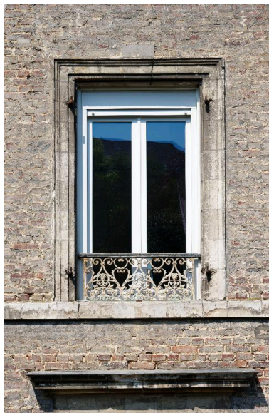
Détail d'une ouverture et de son garde-corps en fer-forgé, premier étage de la façade postérieure. Phot. Thierry Lefébure IVR22_20138000194NUC2A
