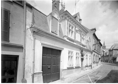
Elévation sur la rue. Phot. Thierry Lefébure IVR22_19930200874P
