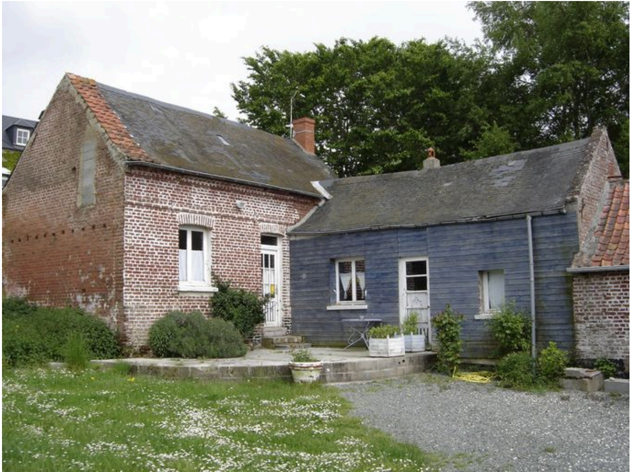
Vue générale du logis et des anciennes étables.
