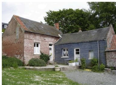
Vue générale du logis et des anciennes étables. Phot. Inès Guérin IVR22_20058005772NUCA
