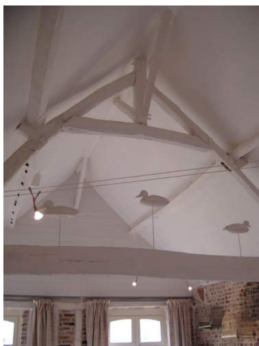
Vue détaillée d'une ferme de la charpente de la grange. Phot. Inès Guérin IVR22_20058005776NUCA
