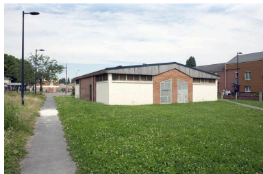
Élévation postérieure et flanc droit. Phot. Pierre Thibaut IVR31_20155901007NUCA
