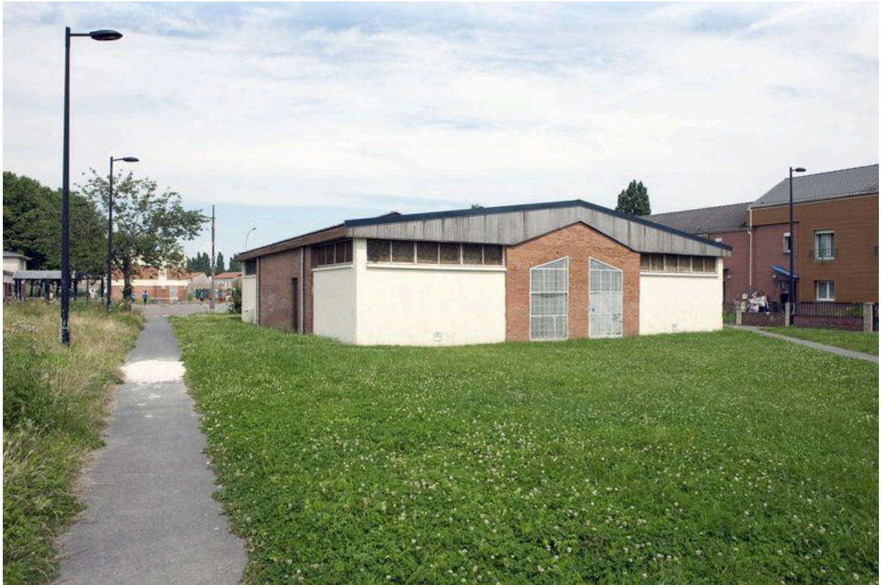
Élévation postérieure et flanc droit.
