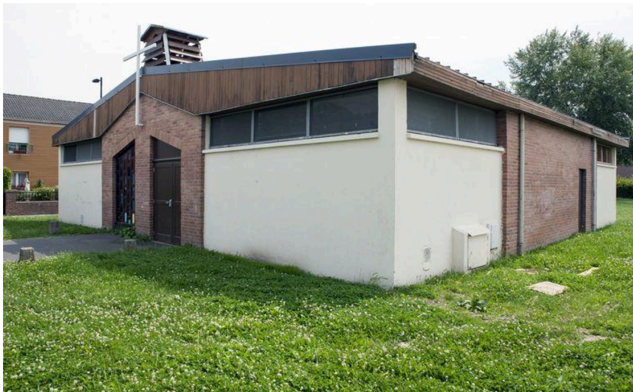
Élévation antérieure et flanc droit.
