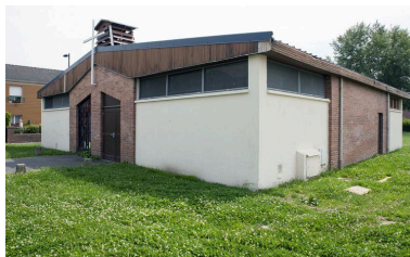
Élévation antérieure et flanc droit. Phot. Pierre Thibaut IVR31_20155901008NUCA
