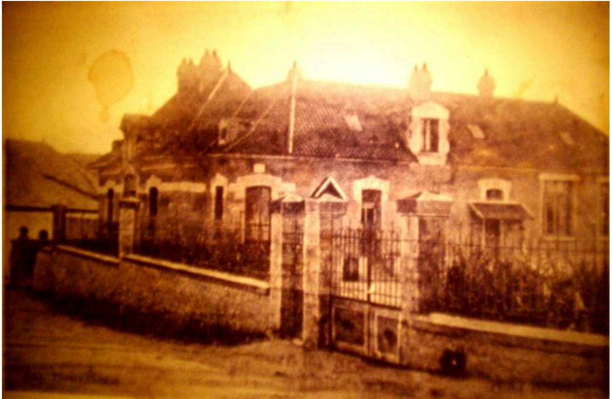
Vue ancienne des écoles (AD Aisne : 4 Fi 318).
