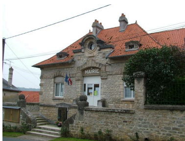
Vue générale. Phot. Inès Guérin IVR22_20030202782NUCA
