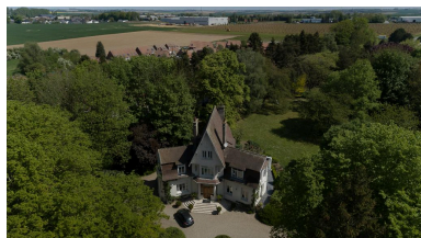
Vue générale de situation depuis la rue du faubourg de Péronne. Phot. Marc Kérignard IVR32_20226200048NUCA
