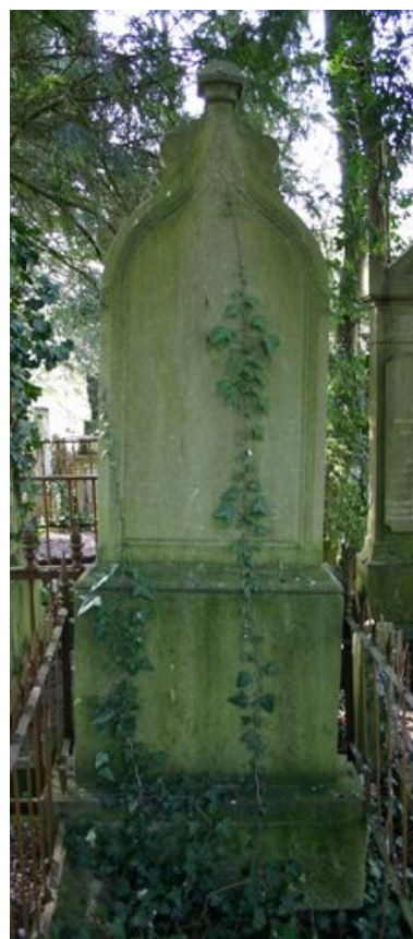
Stèle néogothique (M. Delafosse), vers 1866, Gadré entrepreneur (oeuvre repérée). Phot. Caroline Vincent IVR22_20098000840NUCA
