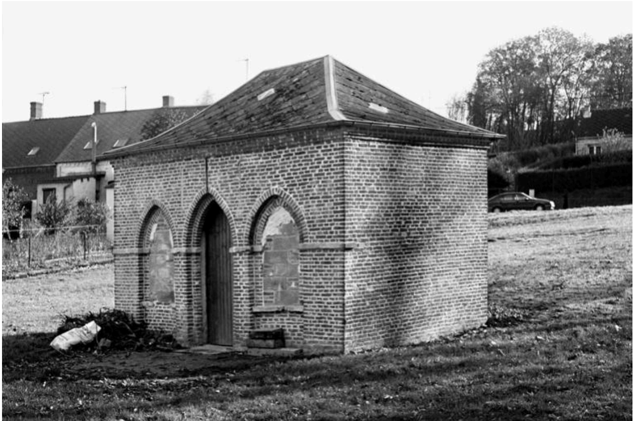
Vue d'un pavillon de jardin, situé dans le parc.
