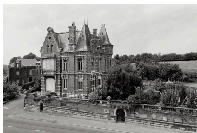
Vue générale de la Villa Delloué-Bertin, depuis la villa Tronquoy.
