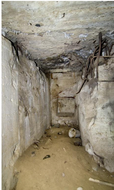
La coursière de tir en enfilade. Dans le fond, la niche à munitions Phot. Jean-Marc Ramette IVR32_20165901168NUCA
