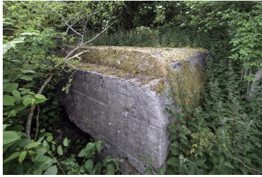
Seule partie visible de l'édifice. Le couvrement, vers le nord-ouest Phot. Jean-Marc Ramette IVR32_20165901164NUCA
