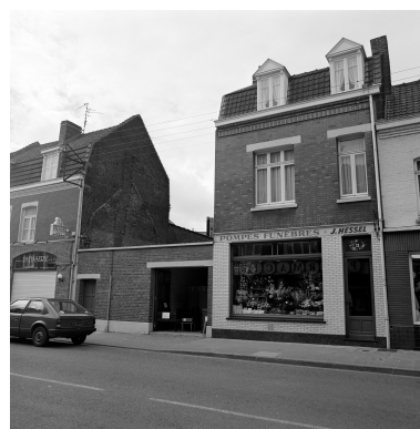
Logement patronal rue des Résistants. Phot. Philippe Dapvril IVR31_19885901387X
