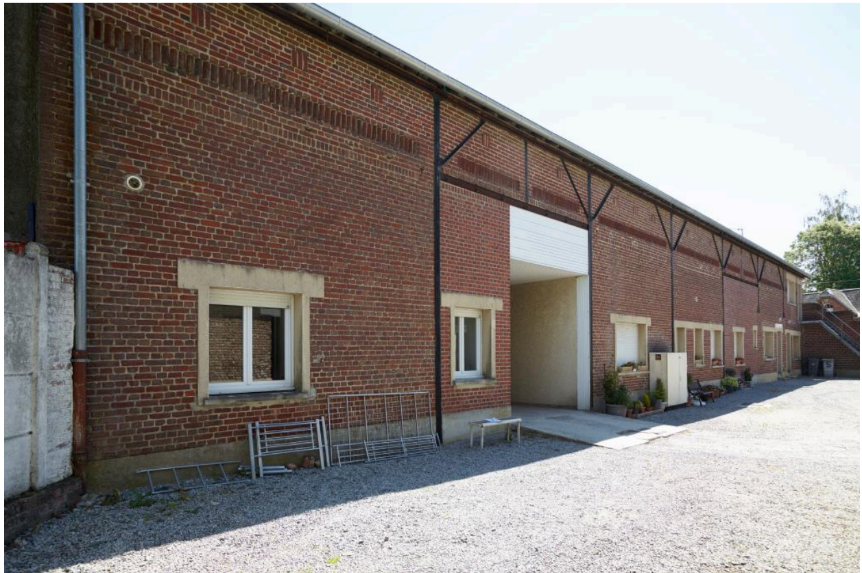
Vue de la façade sur cour de la grange à structure métallique fermant la seconde cour le long de la rue du faubourg de Péronne.
