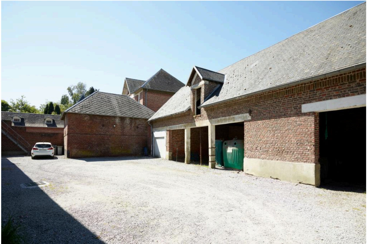
Vue générale de la seconde cour avec l'ensemble hangar-remise-grange, et l'arrière du poulailler situé en fond de cour.
