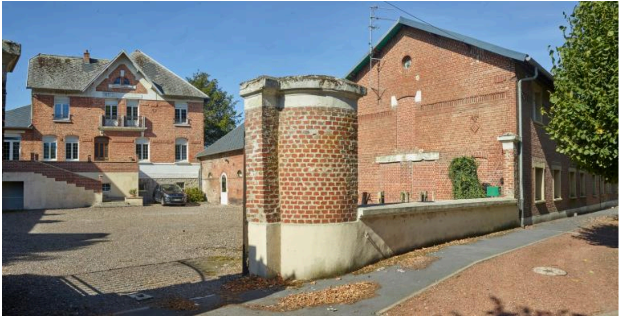
Vue du mur de clôture, du mur pignon du magasin et des maisons ouvrières depuis la cour, avec l'habitation au fond.
