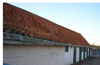
Vue des écuries. Phot. Inès Guérin IVR22_20078005034NUCA
