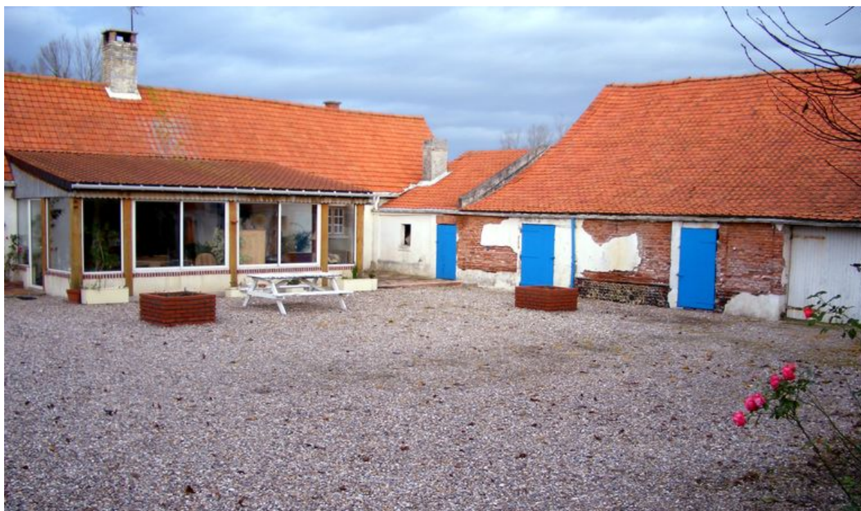
Vue du logis et d'une partie de la grange.
