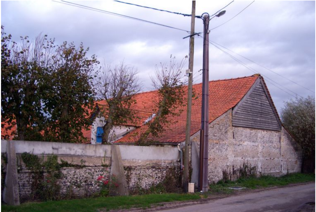
Vue du pignon de la grange.
