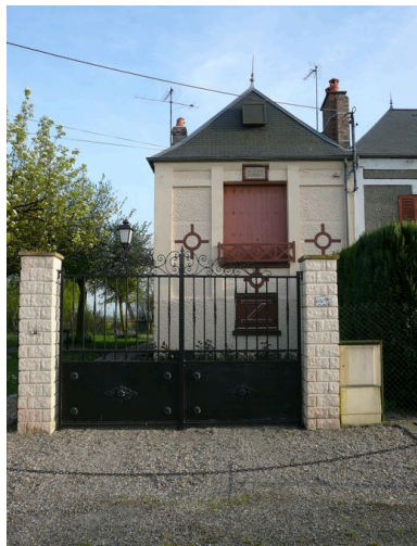
Vue générale. Phot. Inès Guérin IVR22_20078005758NUCA
