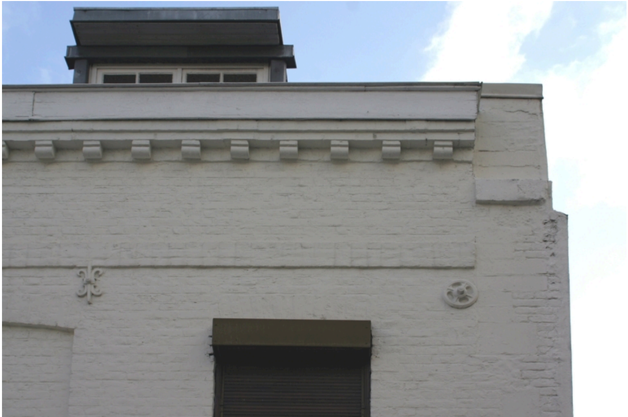
Détail de la façade antérieure : vestiges du pignon est de l'huilerie sur lequel prenaient appui les bureaux.
