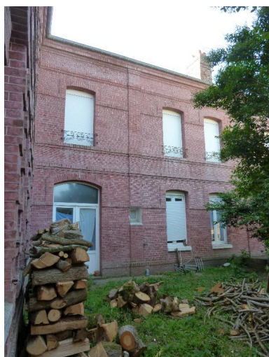
Les anciens ateliers de fabrication. Phot. Frédéric-Nicolas Kocourek IVR22_20158006053NUCA
