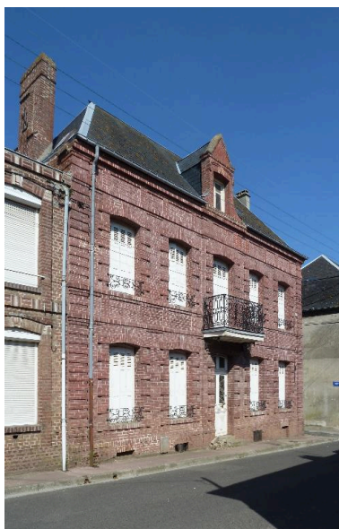
La demeure patronale, rue d'Eu, reconstruite à la fin du 19e siècle pour Albert Lennel. Phot. Frédéric-Nicolas Kocourek IVR22_20158006084NUCA
