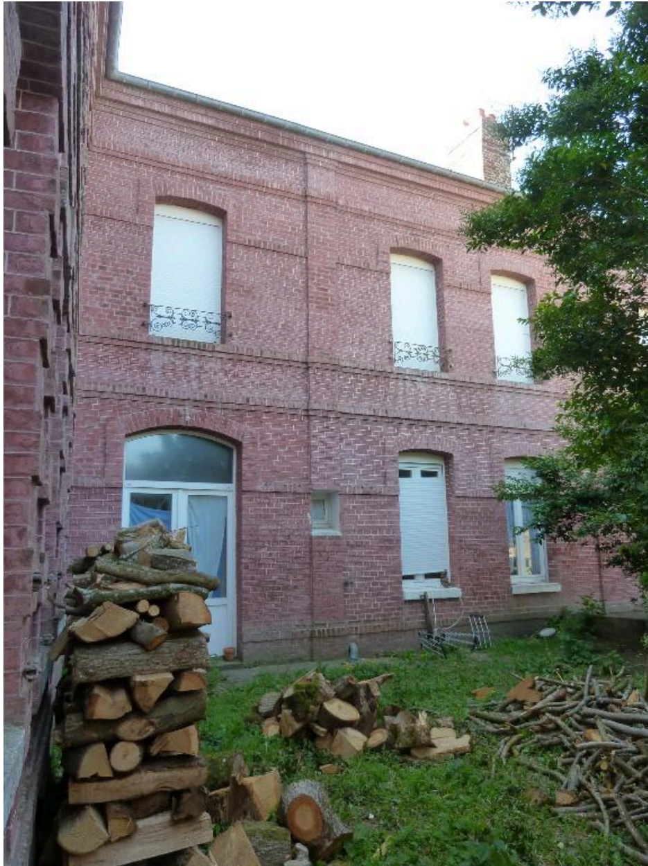
Les anciens ateliers de fabrication.
