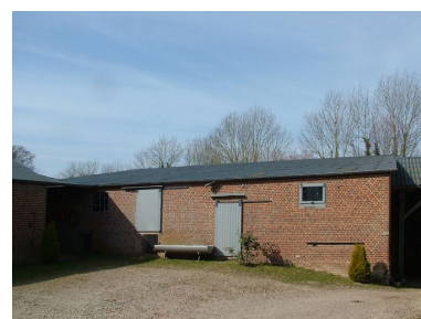
Nouvelle grange. Phot. Frédéric Fournis IVR22_20108001106NUCA
