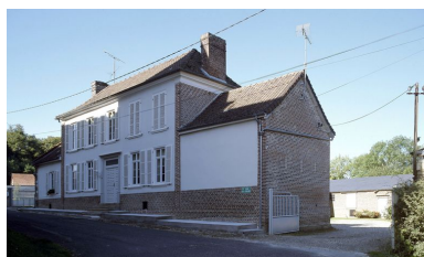
Le logis depuis la rue. Phot. Marie-Laure Monnehay-Vulliet IVR22_20108000323XA
