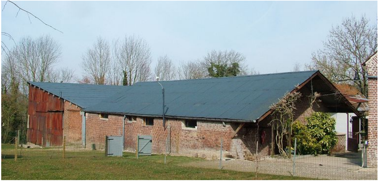
Vue générale des nouvelles étables et de la grange.
