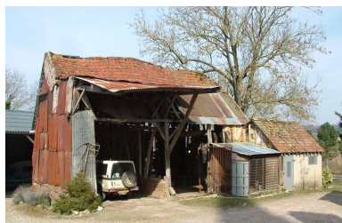
Ancienne grange. Phot. Frédéric Fournis IVR22_20108001103NUCA
