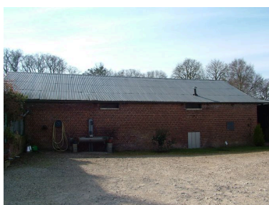
Nouvelle étable. Phot. Frédéric Fournis IVR22_20108001105NUCA
