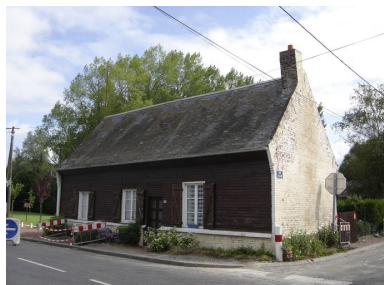
Vue générale. Phot. Inès Guérin IVR22_20058006101NUCA
