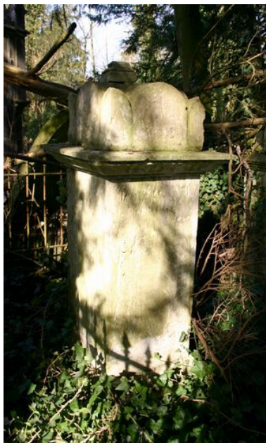
Cippe (gauche), Mangot fils, vers 1823. Phot. Caroline Vincent IVR22_20098000869NUCA
