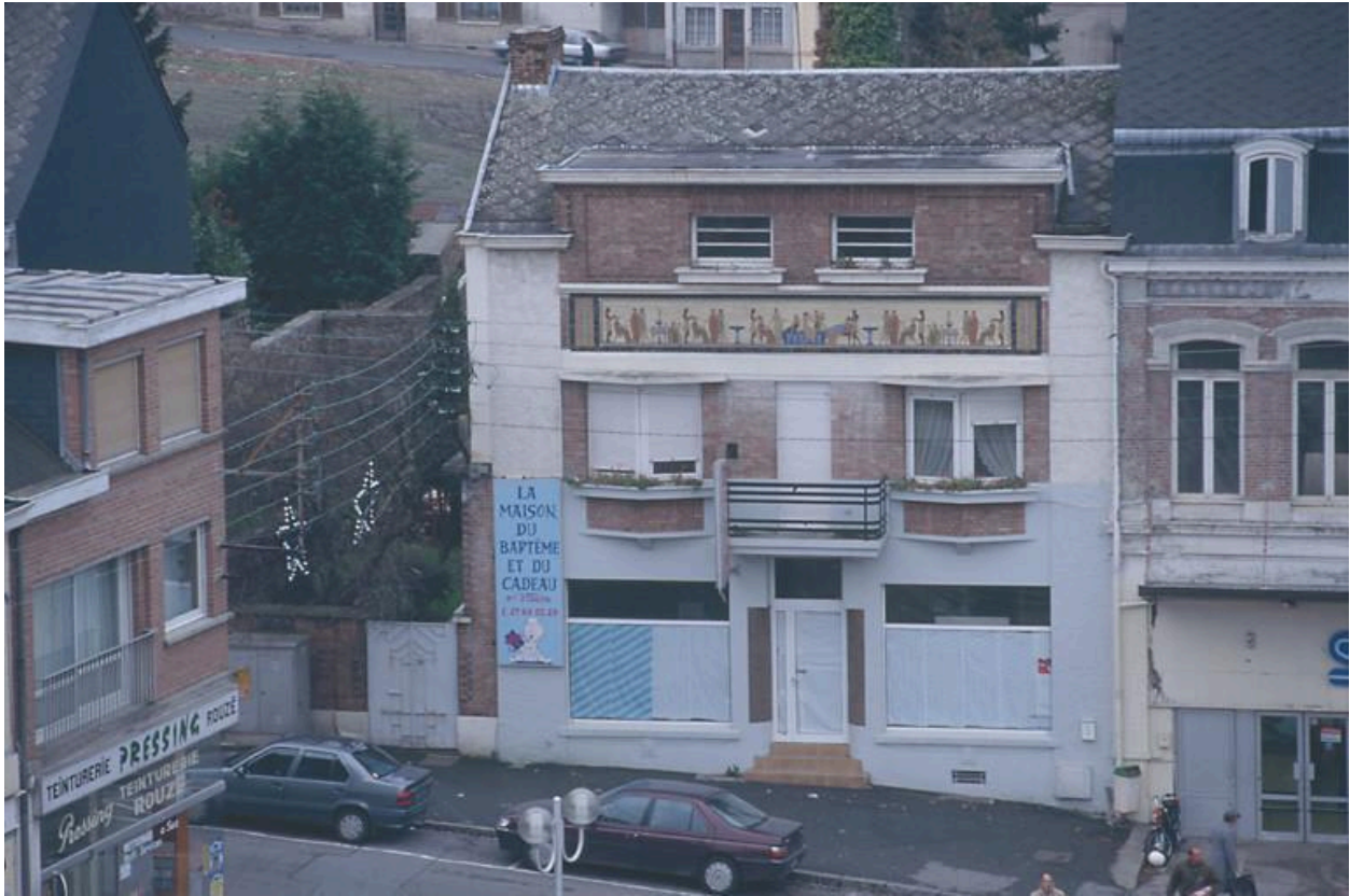
Vue générale de la façade.
