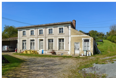
Vue rapprochée de l'ancienne école.
