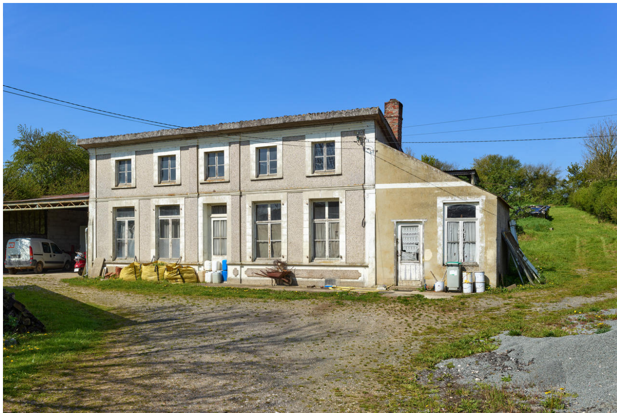
Vue rapprochée de l'ancienne école.
