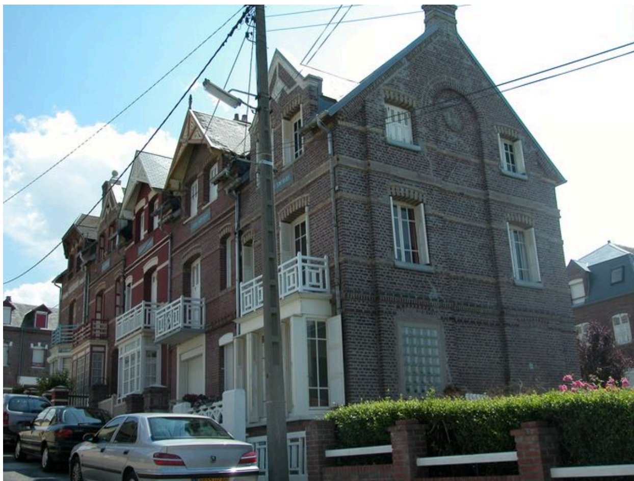
Ensemble des quatre maisons en série, vue depuis le bas de la rue.
