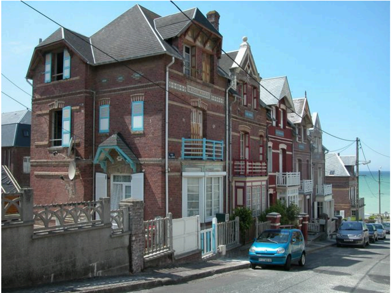
Ensemble des quatre maisons en série avec la maison dite Aigue-Marine au premier plan.
